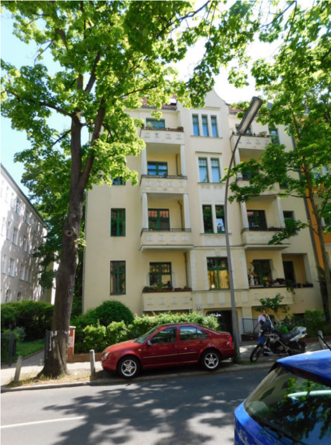
Laubacher Straße 8 in 14197 Berlin-Friedenau WE Nr. 13 im 2. Obergeschoss Seitenflügel - Gebäudeansichten -
