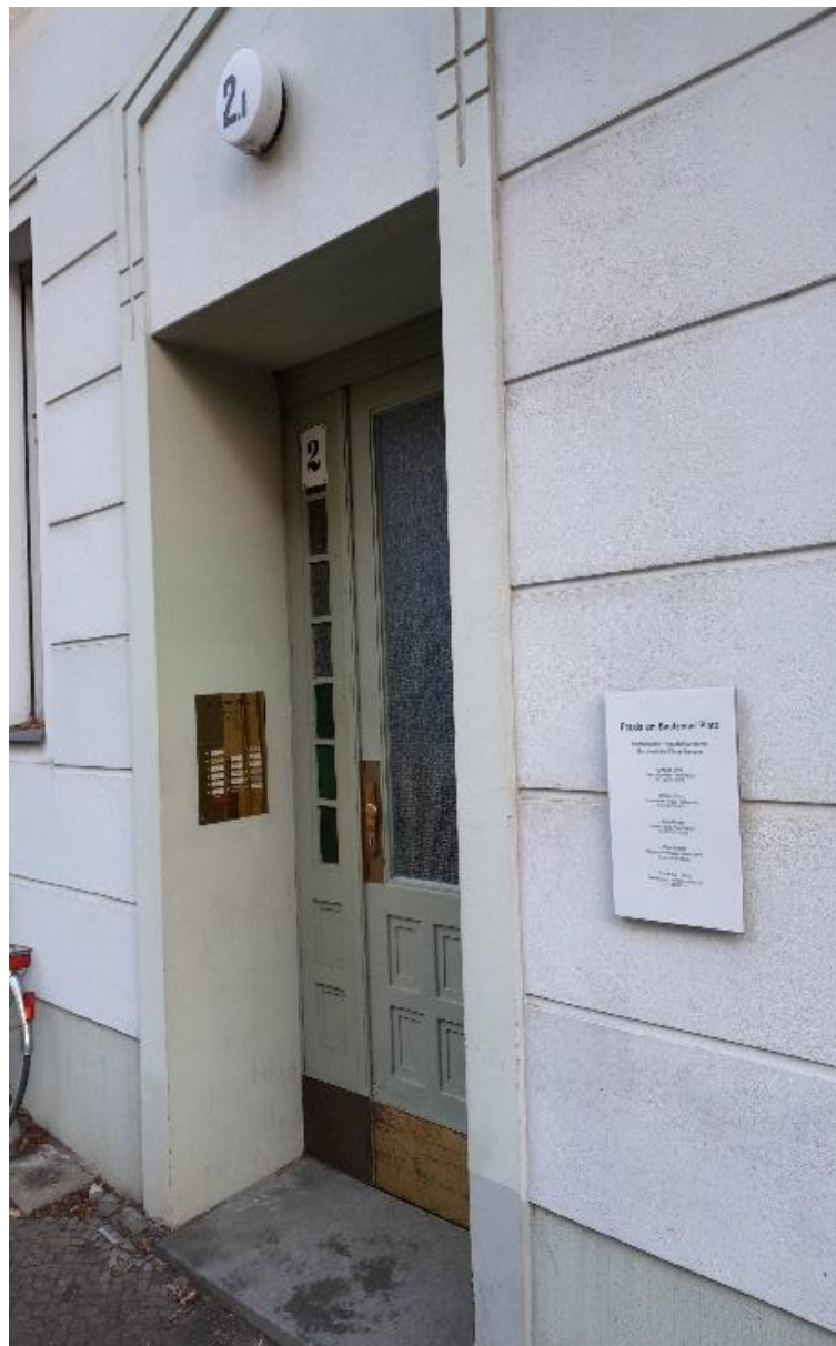
Hauszugangsbereich Bautzener Platz 2-I
