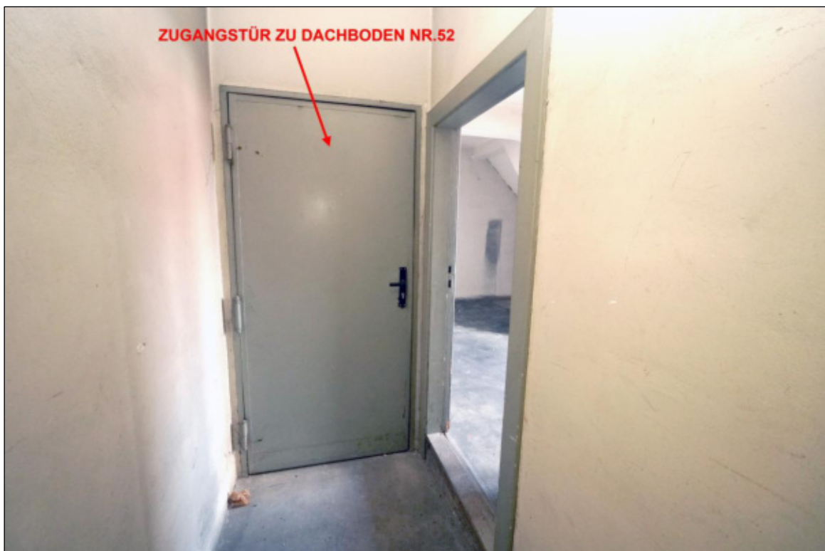
Zugangstür zum Dachboden Nr.52
