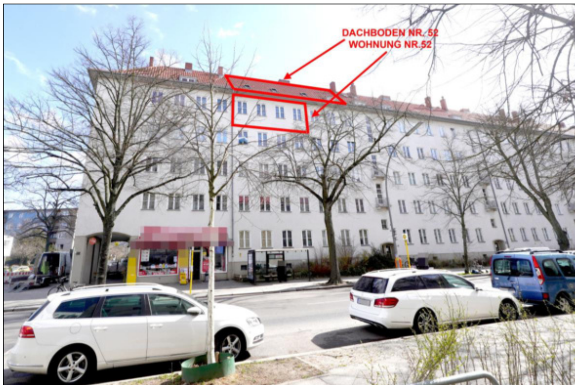
Straßenansicht von der Rubensstraße
