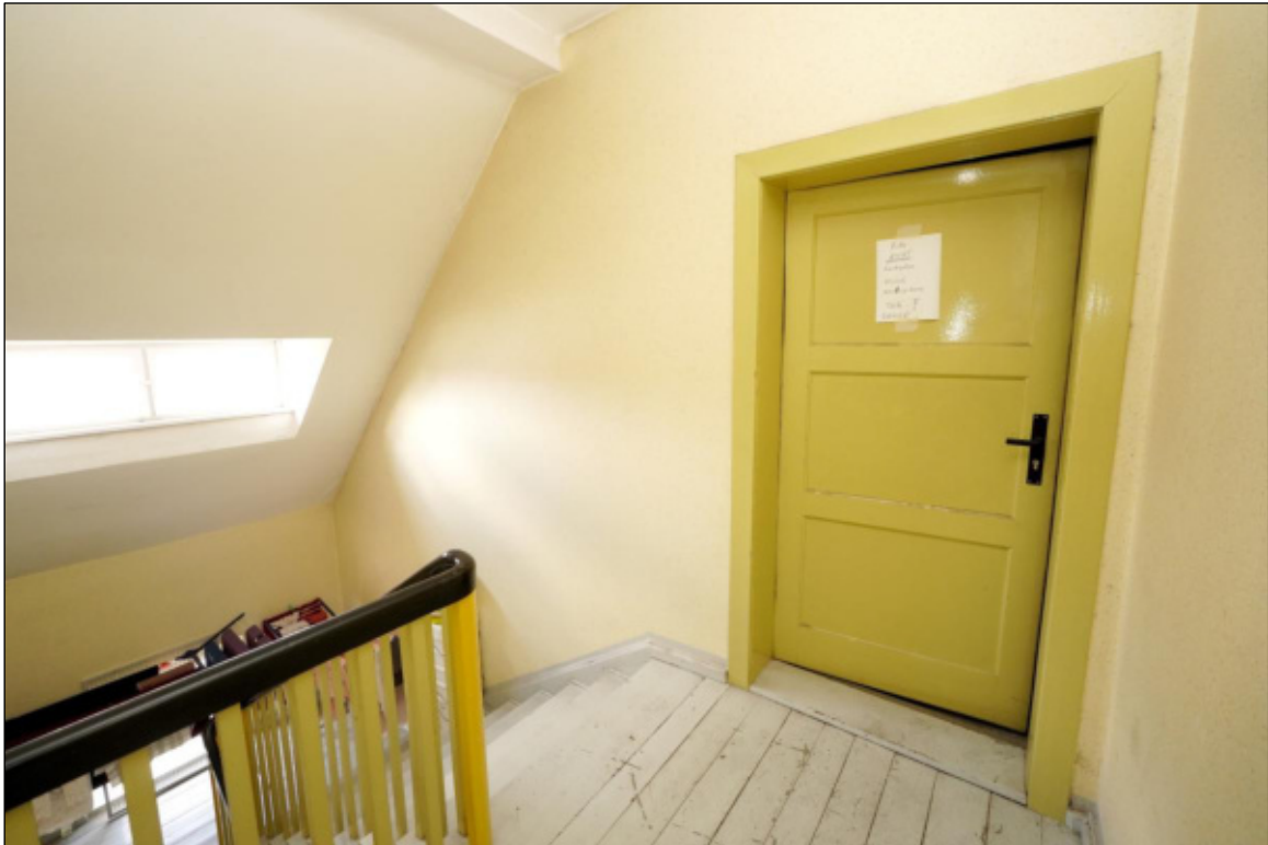
Zugangstür zum Vorflur des Dachbodens Nr.52
