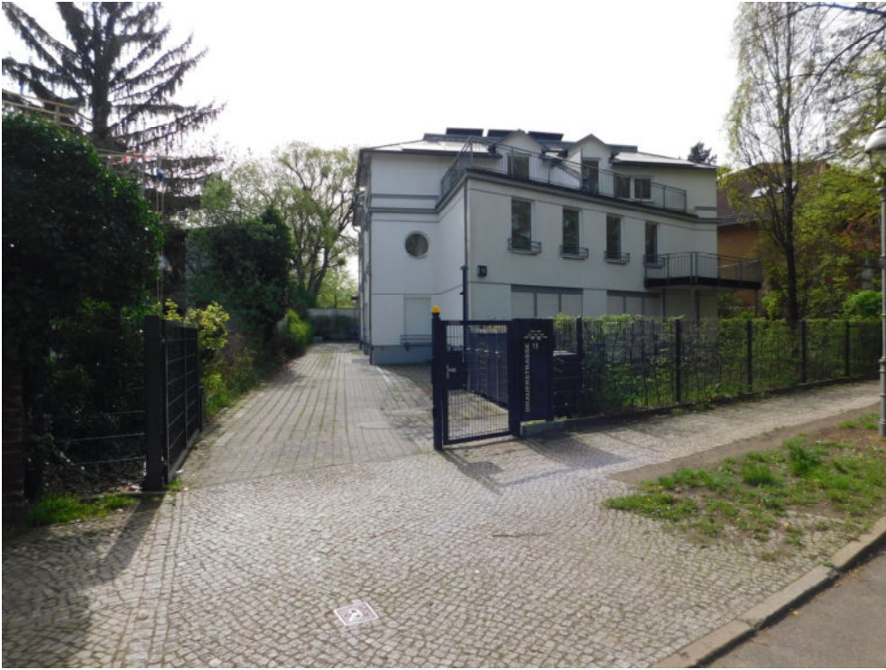
Brauerstraße 15 in 12209 Berlin-Lichterfelde - straßenseitige Gebäudeansicht und WE Nr. 3 im 1. Obergeschoss -
