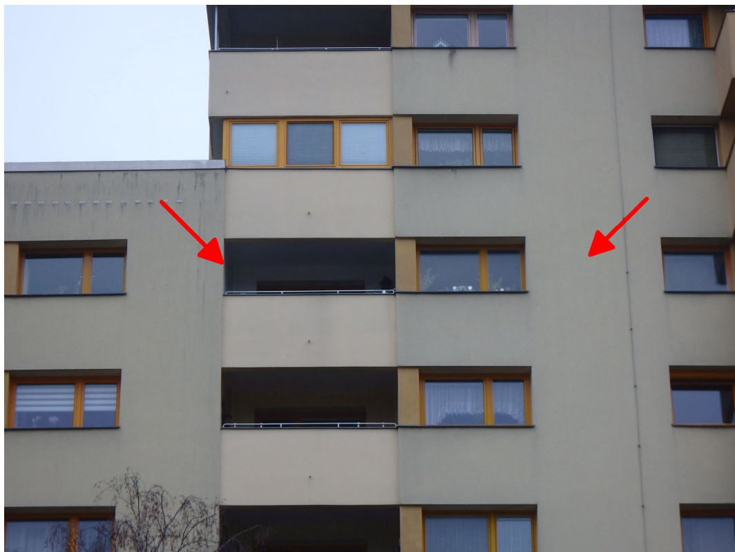
Mehrfamilienwohnhaus (Aufgang Arnulfstraße 105) sowie Eigentumseinheit Nr. 75 Südansicht
