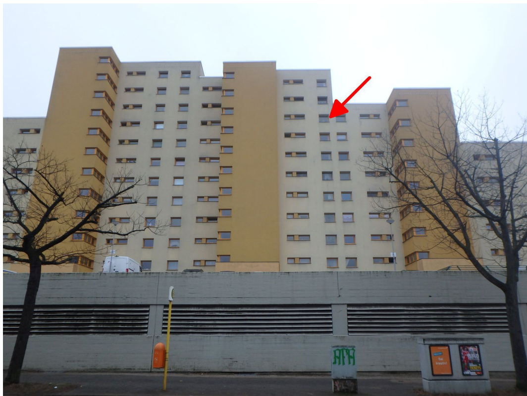
Wohnhausblock (Arnulfstraße 104, 105 u. 106) Nordansicht (Straßenansicht)
