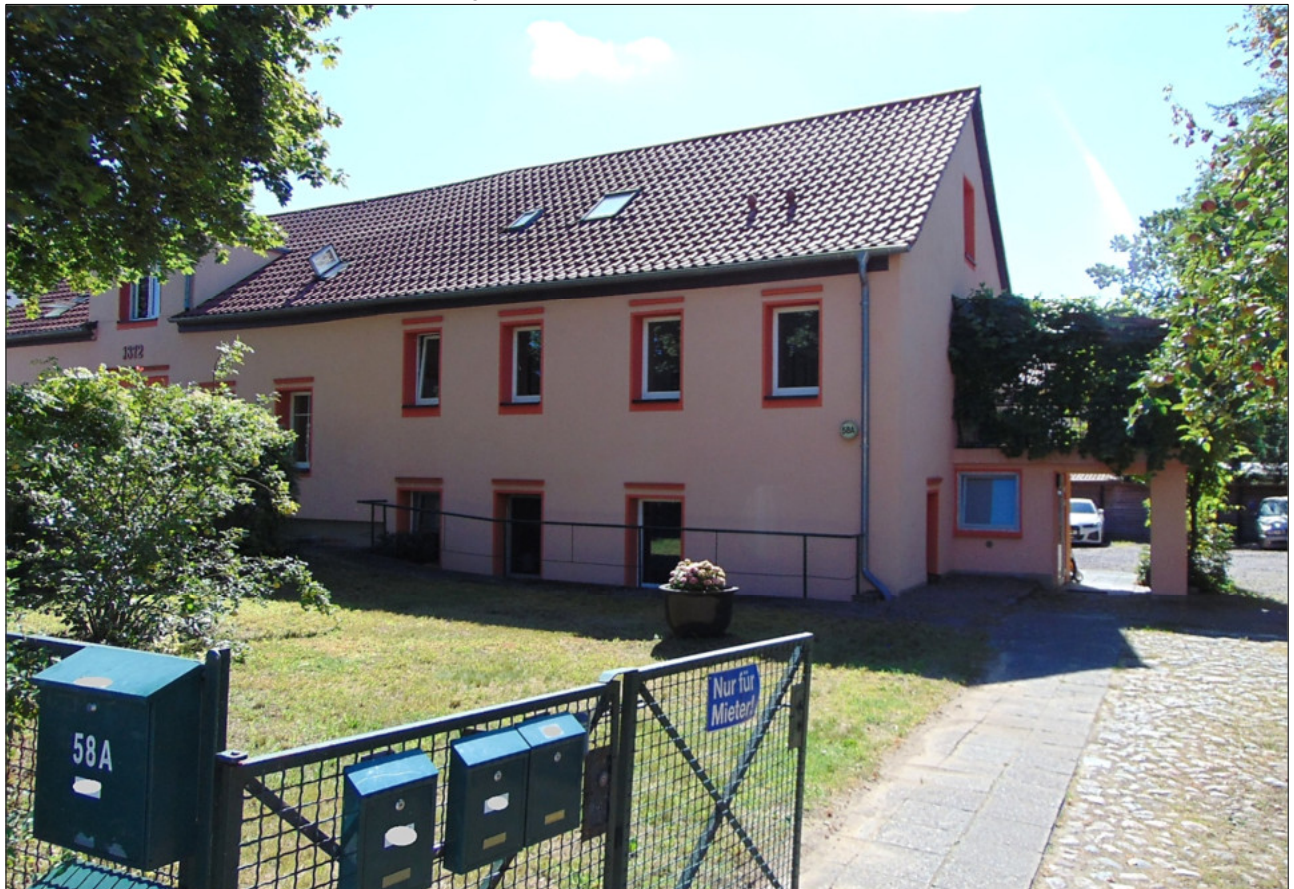
Foto1 Straßenfassade/Nordseite und Westgiebel
