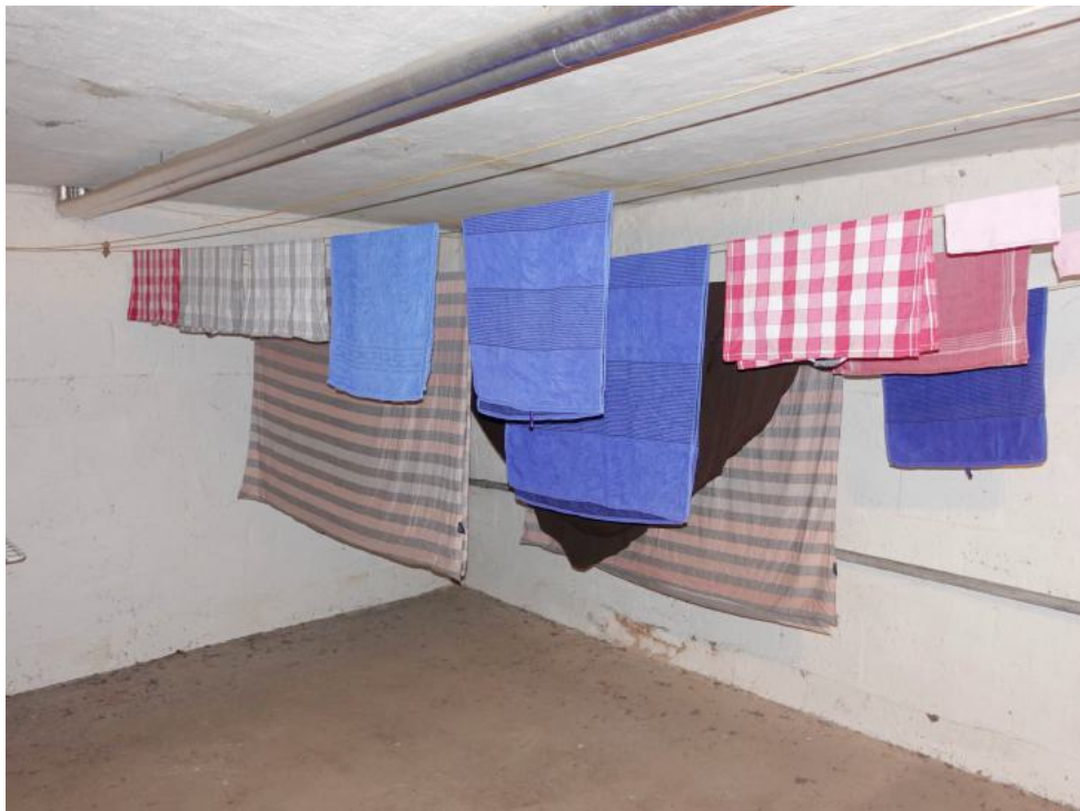
Kellergeschoss, gemeinschaftlicher Trockenraum
