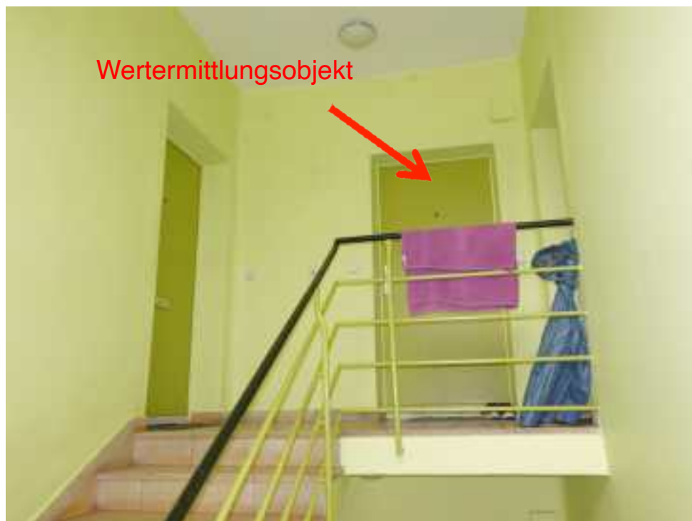
Wohnungseingangstür zur Wohnung WE 27 im 1. OG, Mitte
