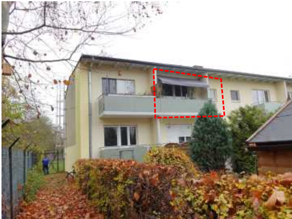
Gartenansicht, die Lage der Wohnung ist markiert.
