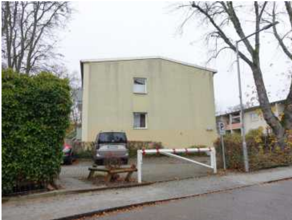
Blick auf die Stirnseite (Ostfassade) des Wohnhauses mit der WE 27
