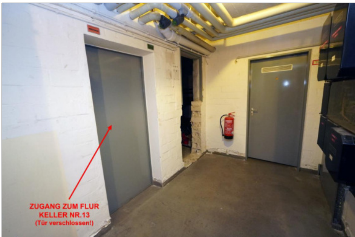
Zugangstür zum Vorflur zu Keller Nr.13
