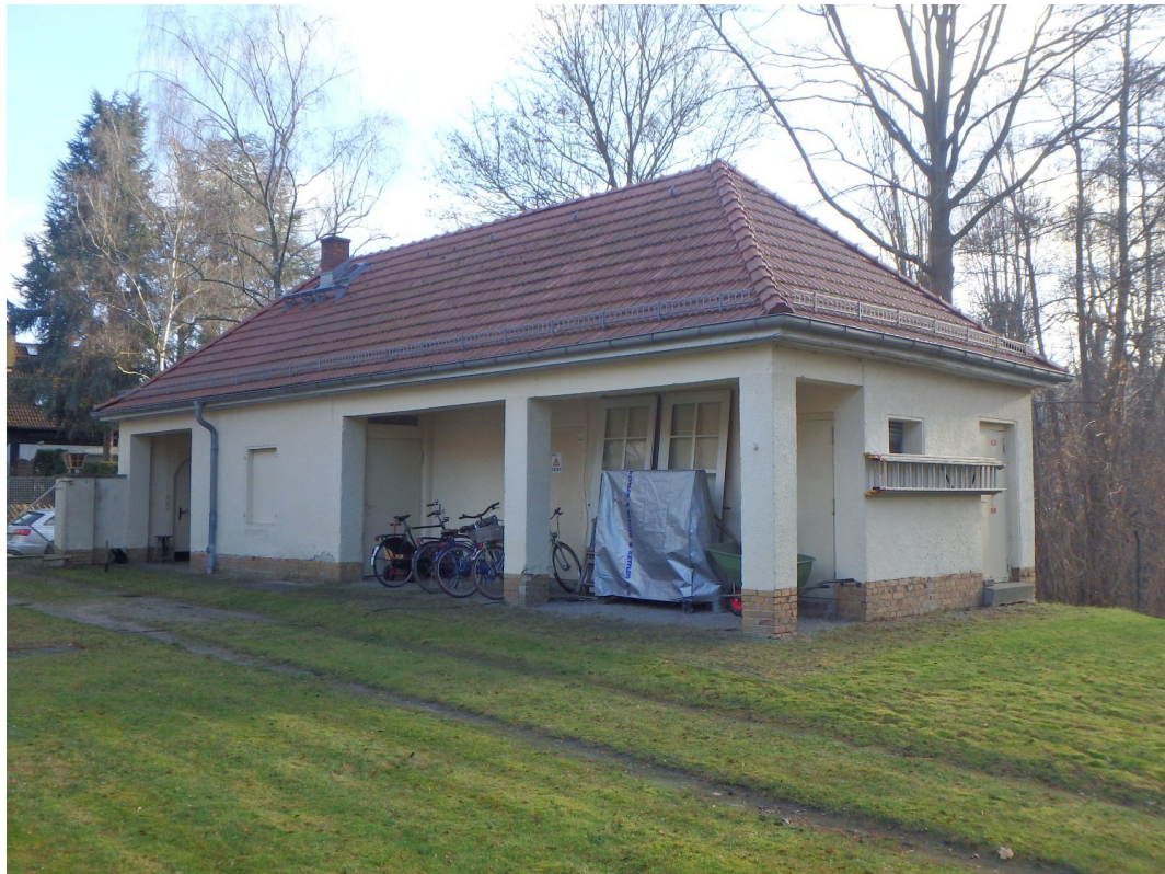
Torhaus Nordwestansicht (Gartenansicht)
