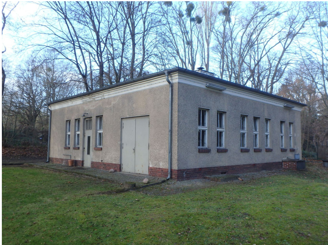
Pumpwerk (außer Betrieb) Nordostansicht
