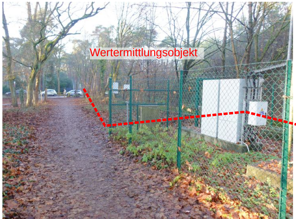
Süd-Ost-Grenze des Grundstücks, Blick zum Hüttenweg
