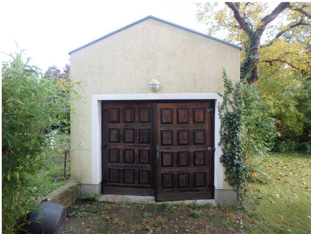
Garage Westansicht (Straßenansicht)
