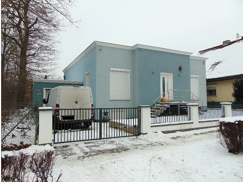
Foto1: Straßenfassade/Südseite und Gebäudewestseite mit Garagenanbau
