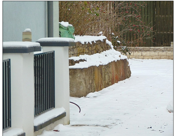
Foto 4 Blick aus dem Nieritzweg auf die gartenseitige Terrasse.
