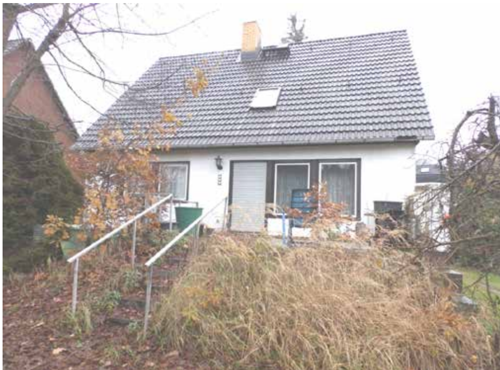
Bild 2: Gartenansicht des Einfamilienhauses
