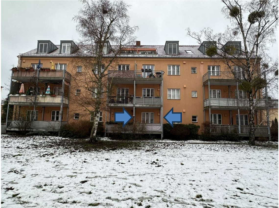
Westfassade mit Balkonanlage
