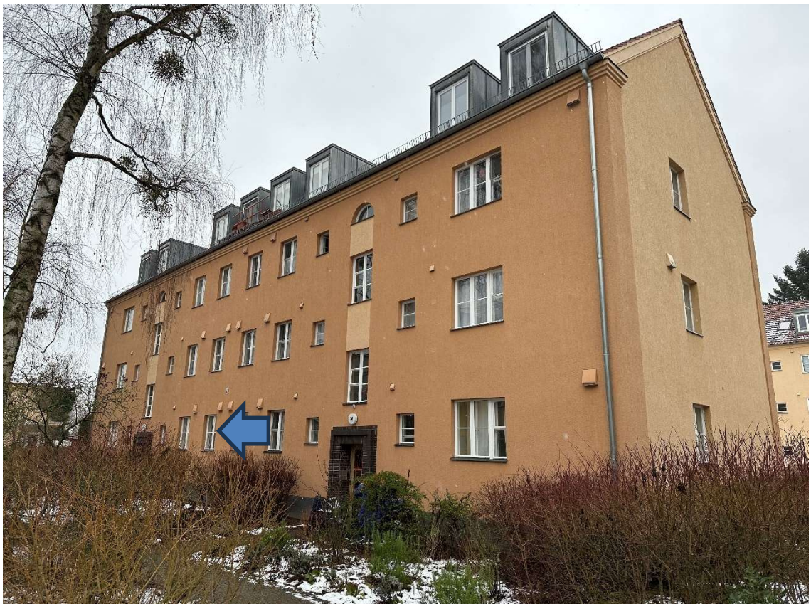
Nördliche Giebelwand und Ostfassade
