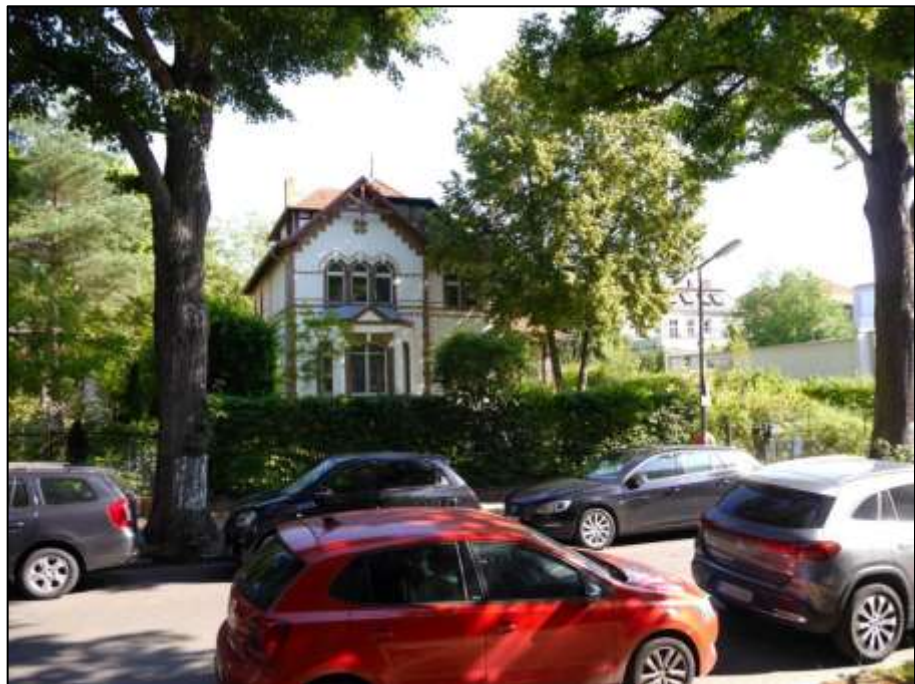
Blick über die Beuckestraße nach Norden auf das Grundstück Beuckestraße 4 mit aufstehendem Wohngebäude als historische Villa und Teil eines denkmalgeschützten Ensembles
