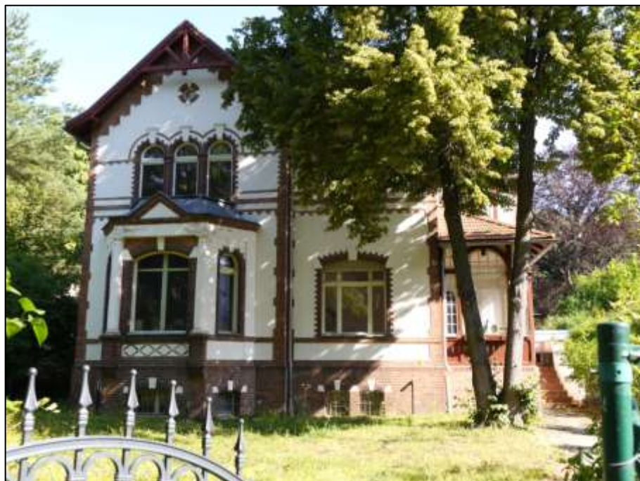
Blick über die Zugangspforte in der straßenseitigen Einfriedung auf die straßenseitige Giebelseite des auf dem Grundstück Beuckestraße 4 aufstehende Wohngebäude als historische Villa aus dem Jahre 1899
