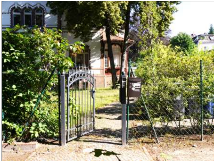
Pforte zur Hauszuwegung in der straßenseitigen Einfriedung mit Klingel- und Gegensprechanlage sowie elektrisch betriebener Türöffneranlage auf dem Grundstück Beuckestr. 4
