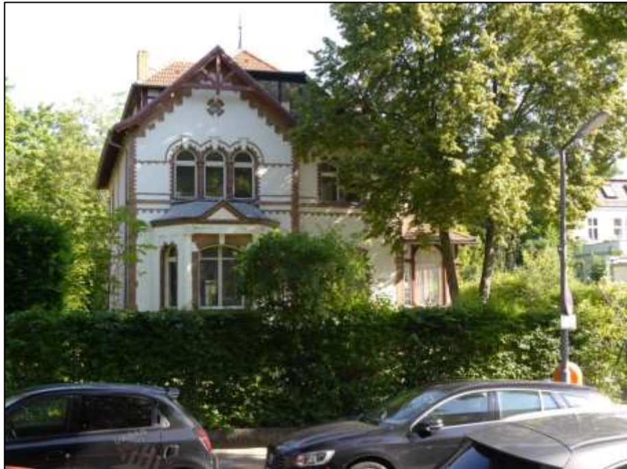
Blick aus der Beuckestraße nach Norden auf das auf dem Grundstück Beuckestraße 4 aufstehende Wohngebäude als historische Villa aus dem Jahre 1899
