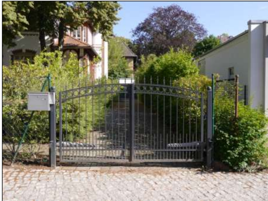
elektrisch betriebene Doppelflügel-Toranlage zur Garagenzufahrt auf dem Grundstück Beuckestr. 4
