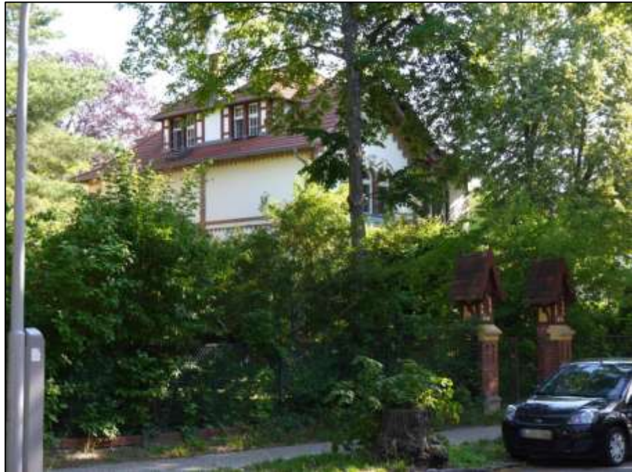
Blick aus der Beuckestraße nach Nord-Osten mit Lage des auf dem Grundstück Beuckestraße 4 aufstehenden Wohngebäudes als historische Villa aus dem Jahre 1899 (zum linken Bauwich orientierte Gebäudefront mit Gauben in der Dachfläche und straßenseitige Giebelseite)
