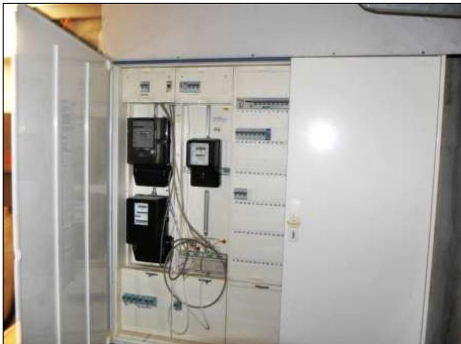
Verteiler- bzw. Stromzählerkasten im Kellergeschoss des Wohngebäudes mit 3 Stromzählern für die beiden Wohnungen und für das neutrale Treppenhaus bzw. das Kellergeschoss und die Außenanlagen bzw. die Garage, wobei die Garage vermtl. auf die EG-WE geschaltet ist
