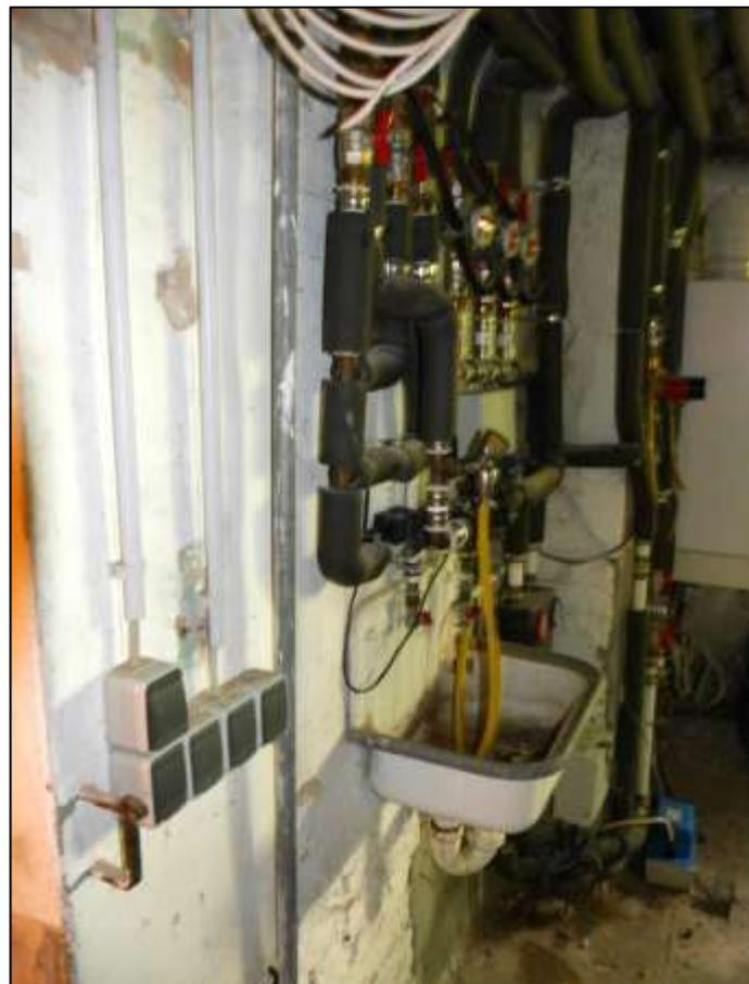
Heizzentrale mit Ausgussbecken und Füllarmatur der Heizkreisläufe sowie an der darüber liegenden Wand aufgehende Heizleitung
