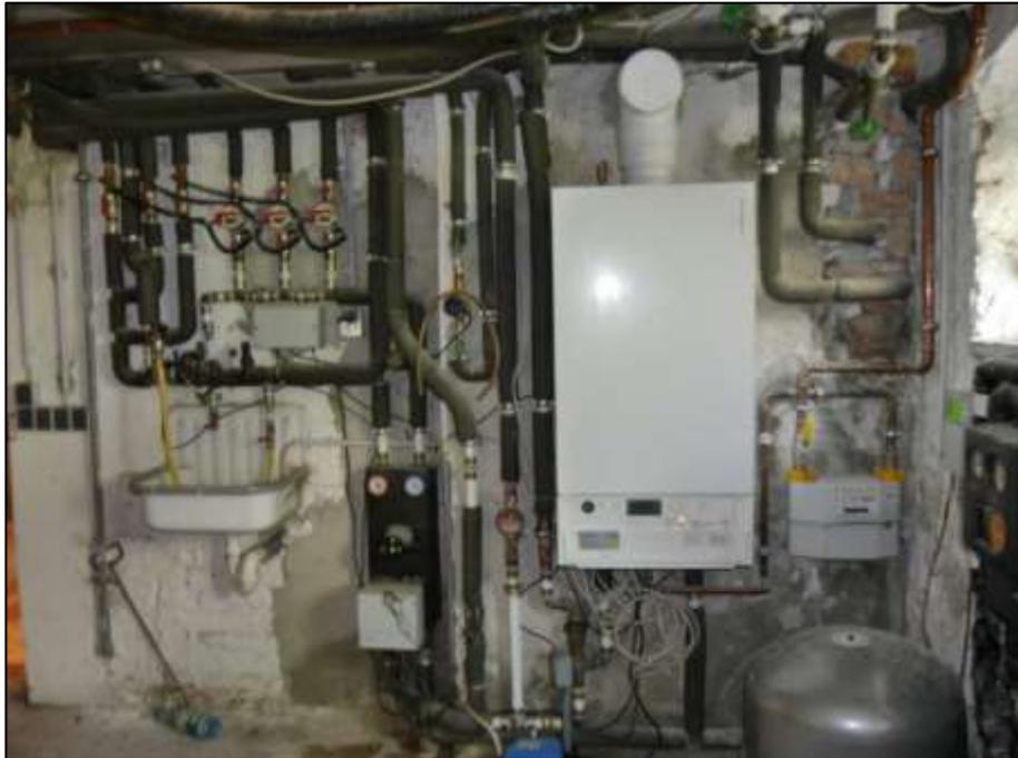
Heizzentrale mit Gas-Kombitherme und Heizkreislaufverteilung sowie mit Ausgussbecken und Füllarmatur der Heizungsanlage und Gasanschluss mit Gaszähler vor der gartenseitigen Außenfront im Kellergeschoss des Wohngebäudes
