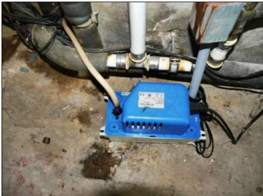
automatische Kondensat-Pumpe der Heizungsanlage zur Einleitung des aus dem Rauchgas ausfallenden Kondensats in die Abwasserleitung
