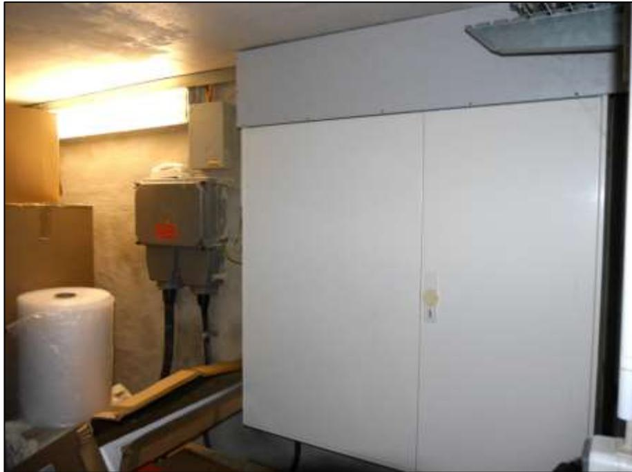
Panzersicherung und Verteiler- bzw. Stromzählerkasten im Kellergeschoss des Wohngebäudes
