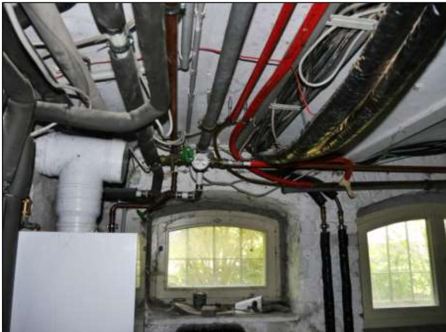
Außenfront der Heizzentrale im Kellergeschoss des Wohngebäudes mit über Terrain liegenden gartenseitigen Kellerfenstern - links im Bild wandverwahrte Gas-Kombitherme der Heizungsanlage
