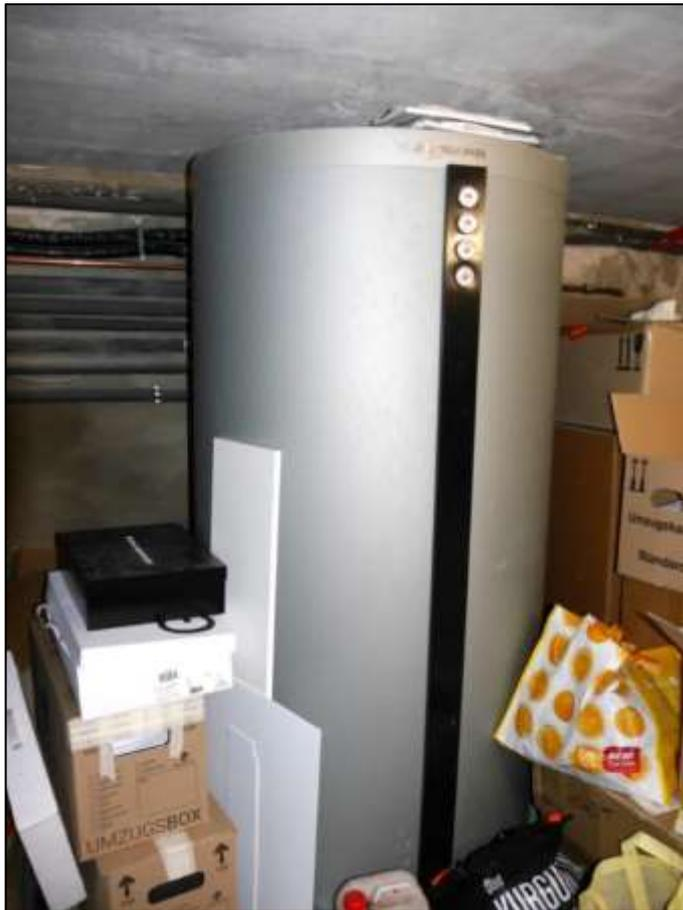
Warmwasserspeicher der zentralen Warmwasserversorgung im Kellergeschoss des Wohngebäudes
