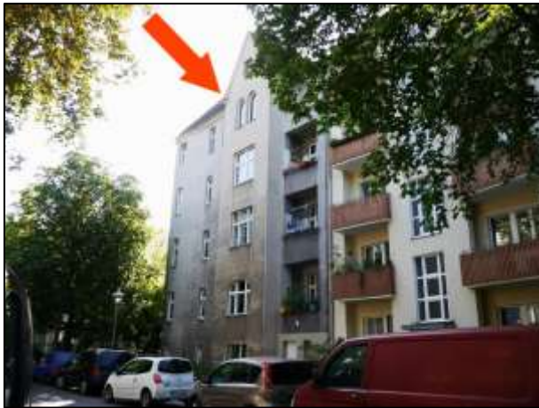
Wohngebäude a.d. Grdst. Poschingerstr. 31
