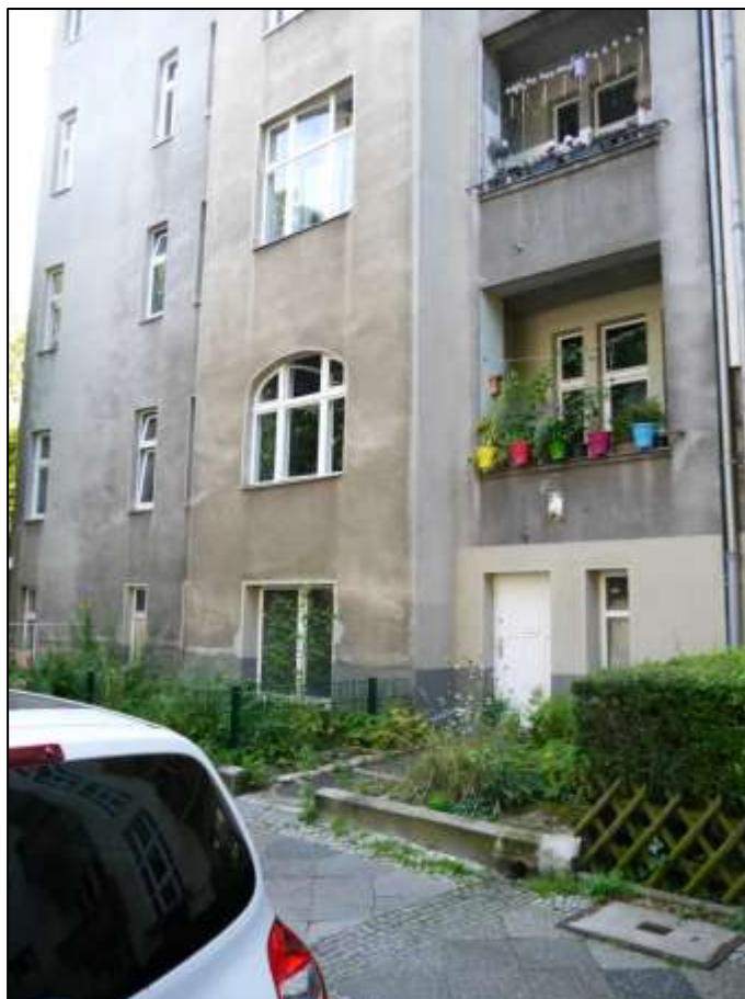
straßenseitige Gebäudefront mit direktem Zugang zu der im nominellen Untergeschoss belegenen Gewerbeeinheit
