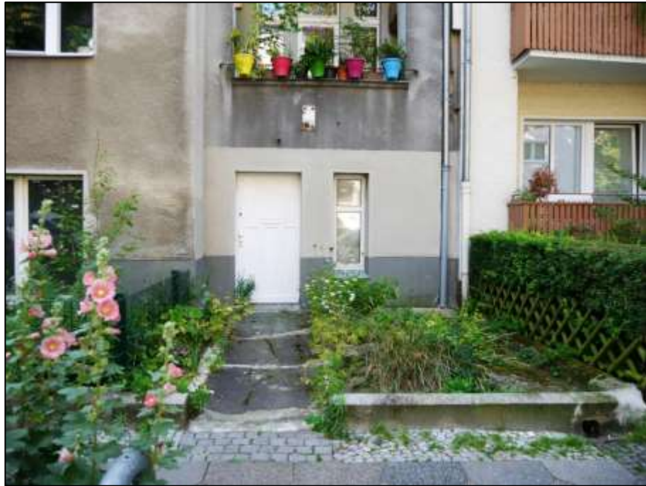
straßenseitige Gebäudefront mit direktem Zugang zu der im nominellen Untergeschoss belegenen Gewerbeeinheit
