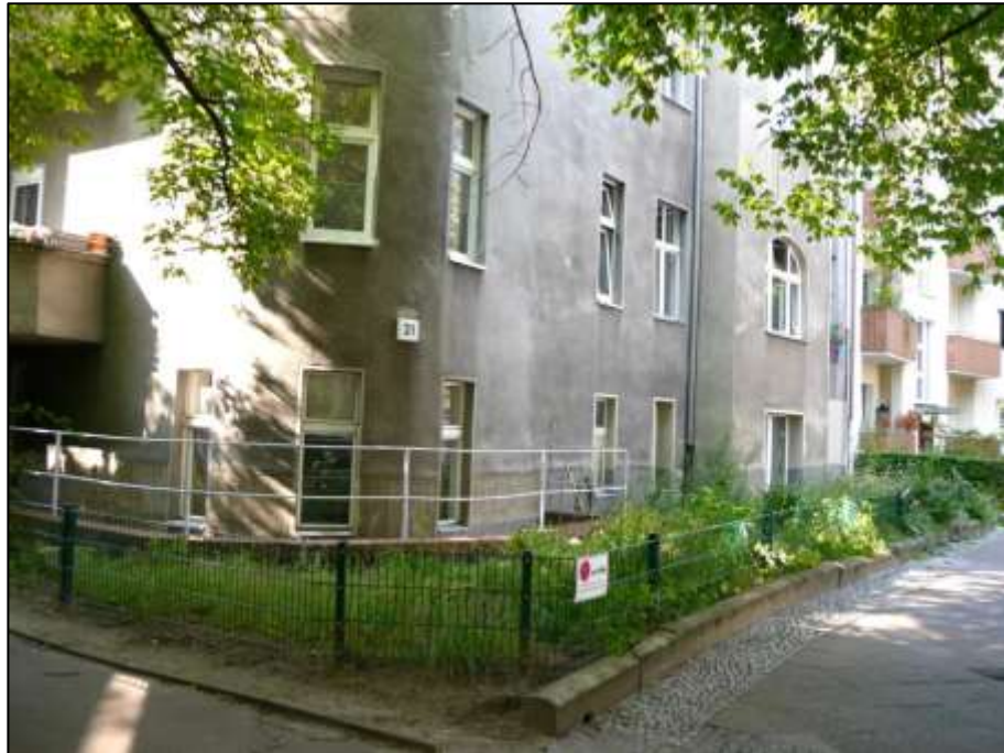
straßenseitige Gebäudeecke mit im Untergeschoss belegener ehemaliger Hausmeisterwohnung hinter dem Lichtgraben und dahinter anbindende Gewerbeeinheit rechts im Bild
