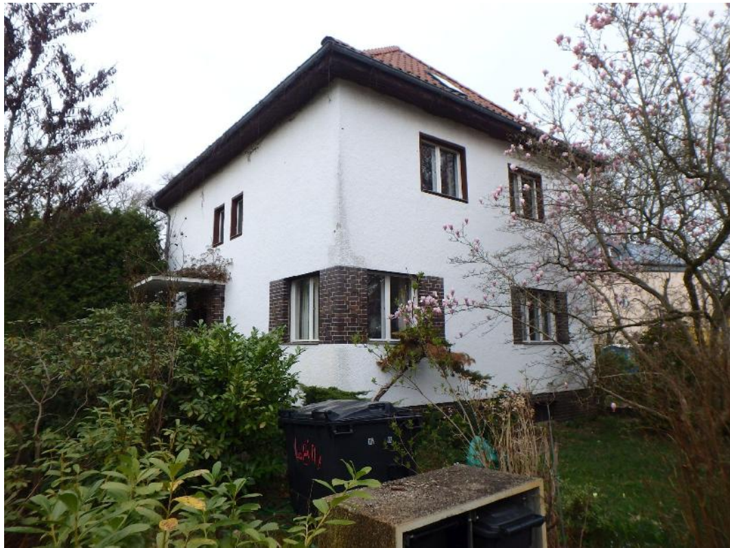
Einfamilienhaus Westansicht (Straßenansicht)
