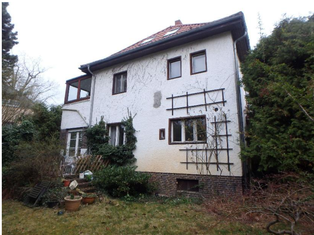
Einfamilienhaus Nordostansicht (Gartenansicht)
