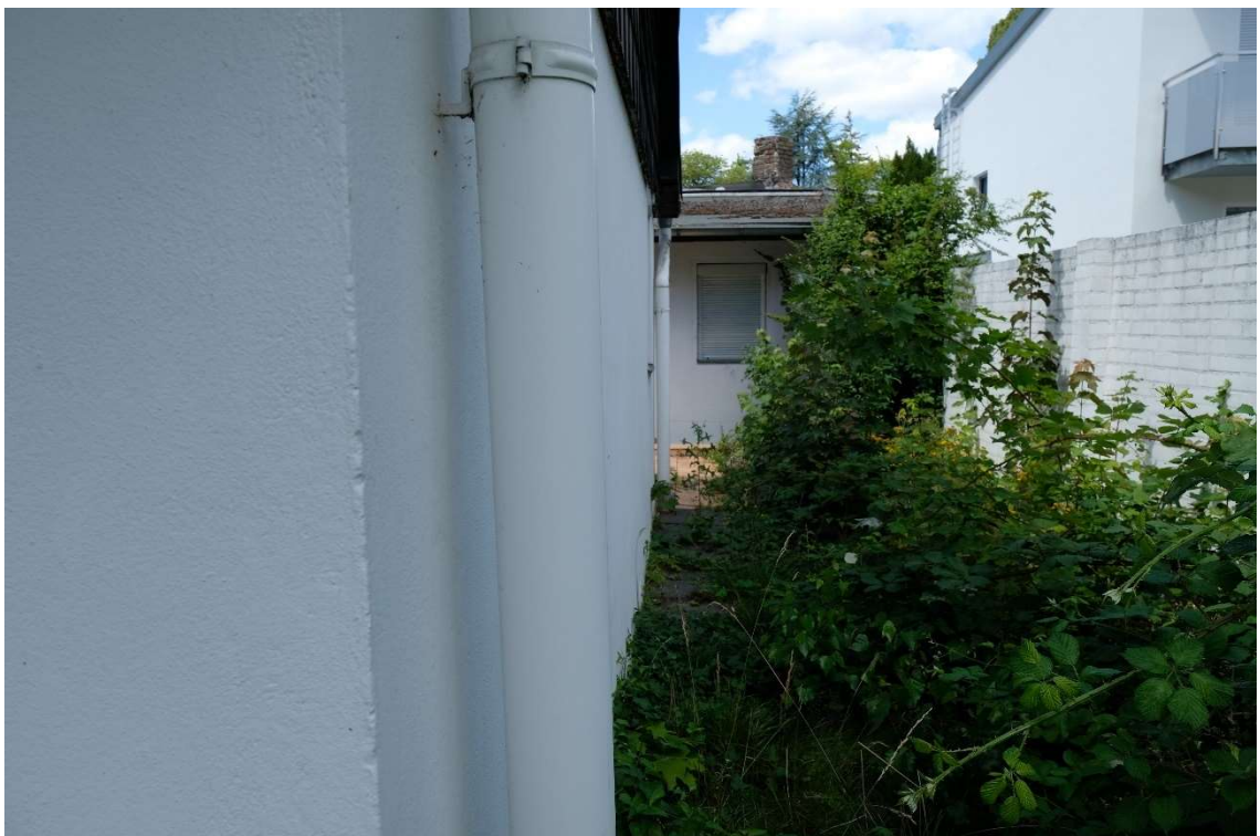
Zugang Wohngebäude von der Nordseite
