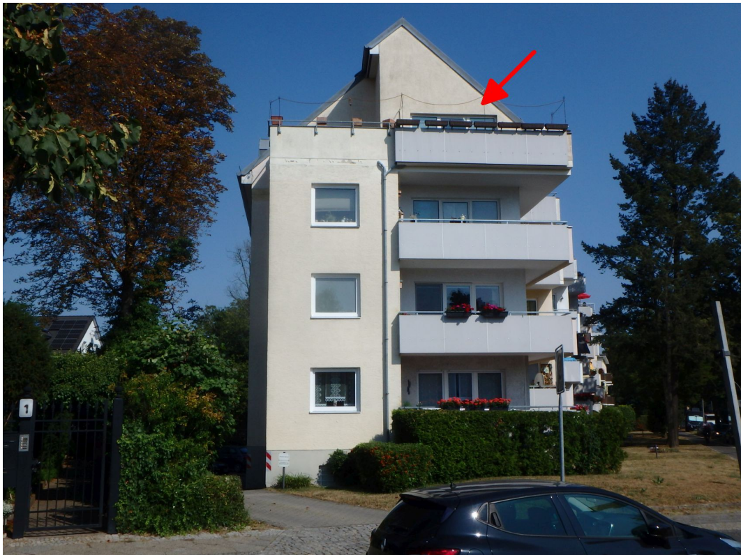
Mehrfamilienwohnhaus (Aufgang Hildburghauser Straße 218) Westansicht (Straßenansicht Hochstraße)
