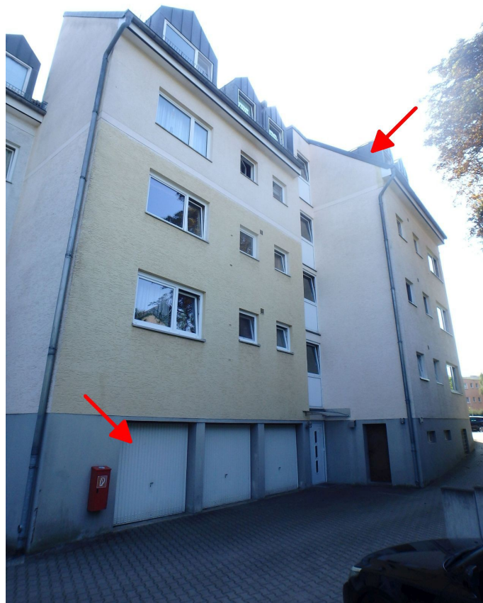
Mehrfamilienwohnhaus (Aufgang Hildburghauser Straße 218) Nordostansicht (Hofansicht)
