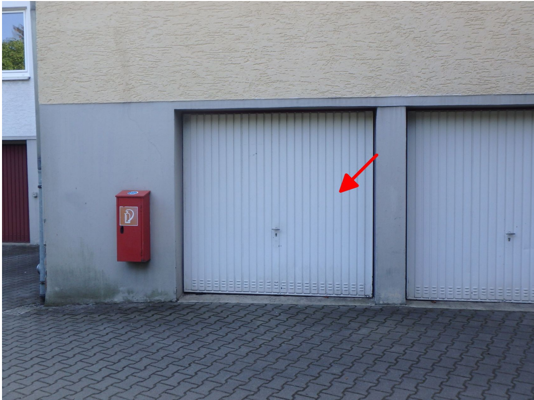
Garage (Sondernutzungsrecht Nr. 3) Nordansicht
