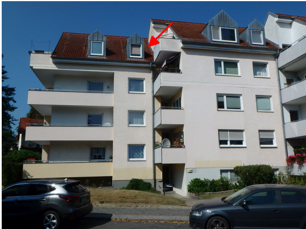
Mehrfamilienwohnhaus (Aufgang Hildburghauser Straße 218) Südansicht (Straßenansicht Hildburghauser Straße)
