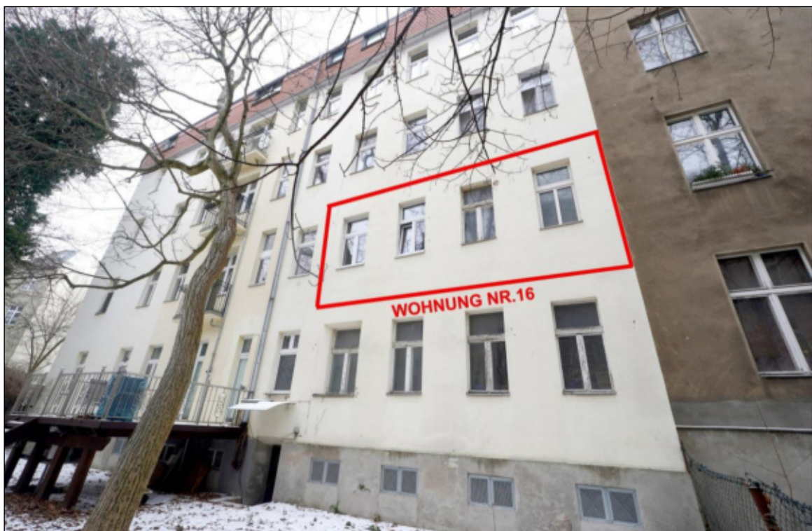
Ansicht des Gartenhauses vom zweiten Hof
