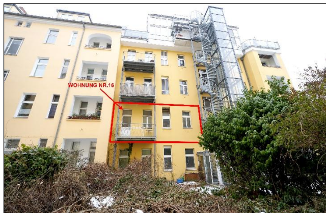
Ansicht vom ersten Hof
