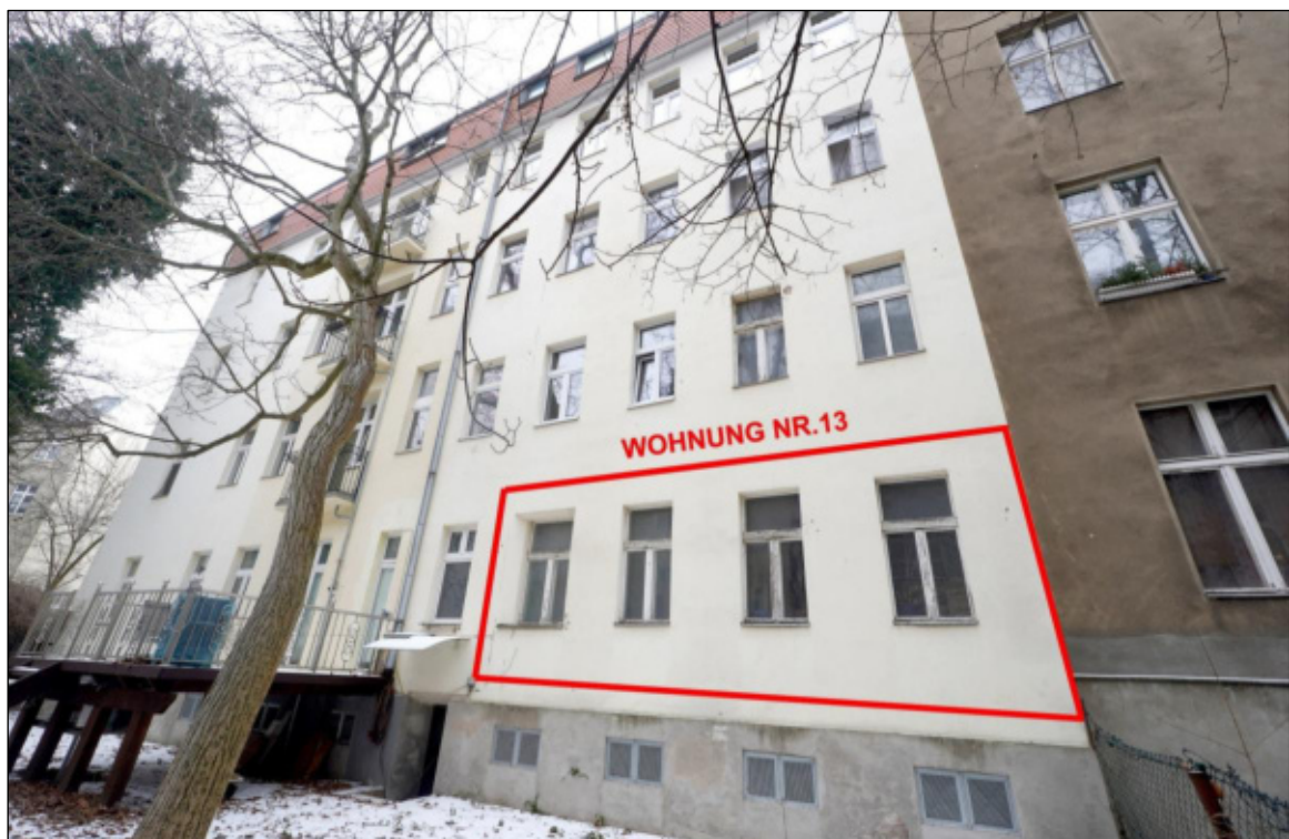
Ansicht des Gartenhauses vom zweiten Hof
