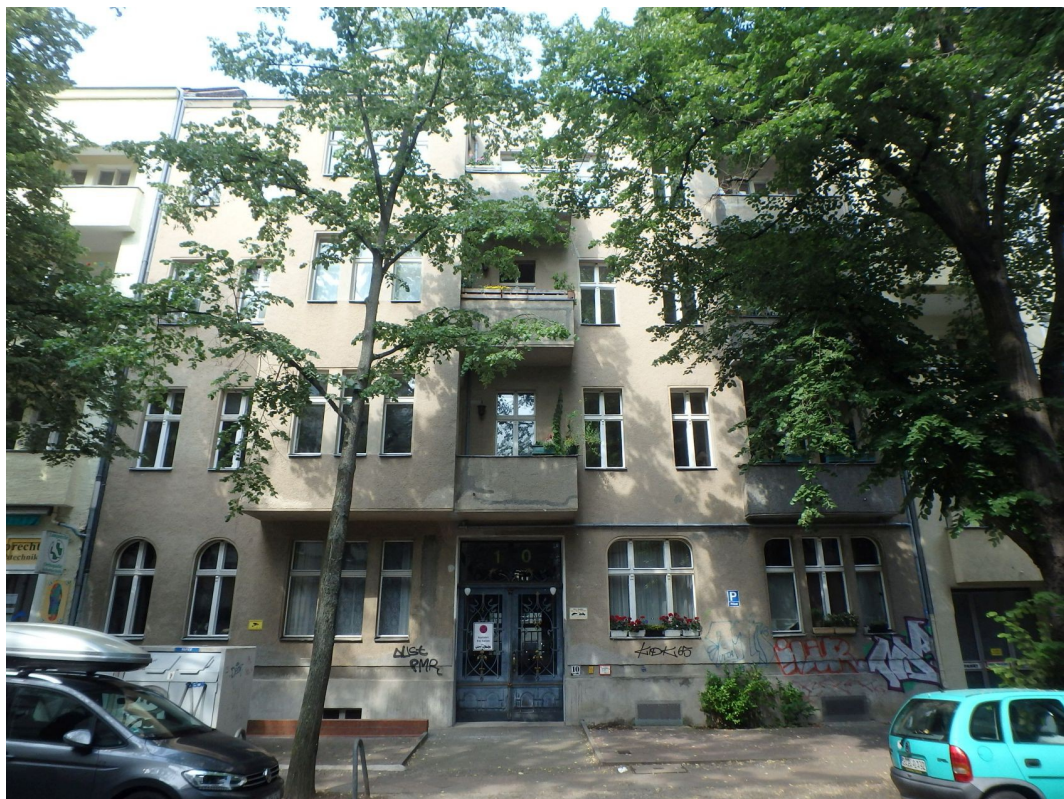
Mehrfamilienwohnhaus (Vorderhaus) Südwestansicht (Straßenansicht)
