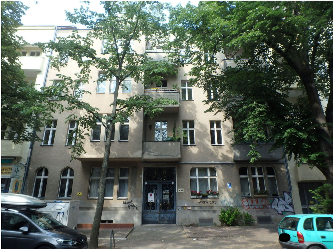
Mehrfamilienwohnhaus (Vorderhaus) Südwestansicht (Straßenansicht)
