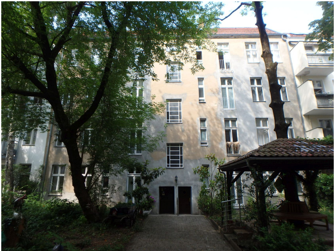
Mehrfamilienwohnhaus (Hinterhaus) Südwestansicht (Hof-I-Ansicht)
