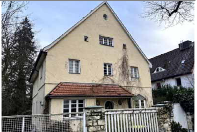
2-geschossiges, unterkellertes Einfamilienhaus, ausgebautes Dachgeschoss, freistehend
