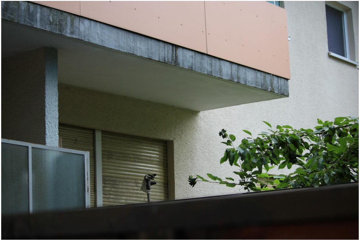
Rollläden Zimmer der Wohnung Nr. 79
