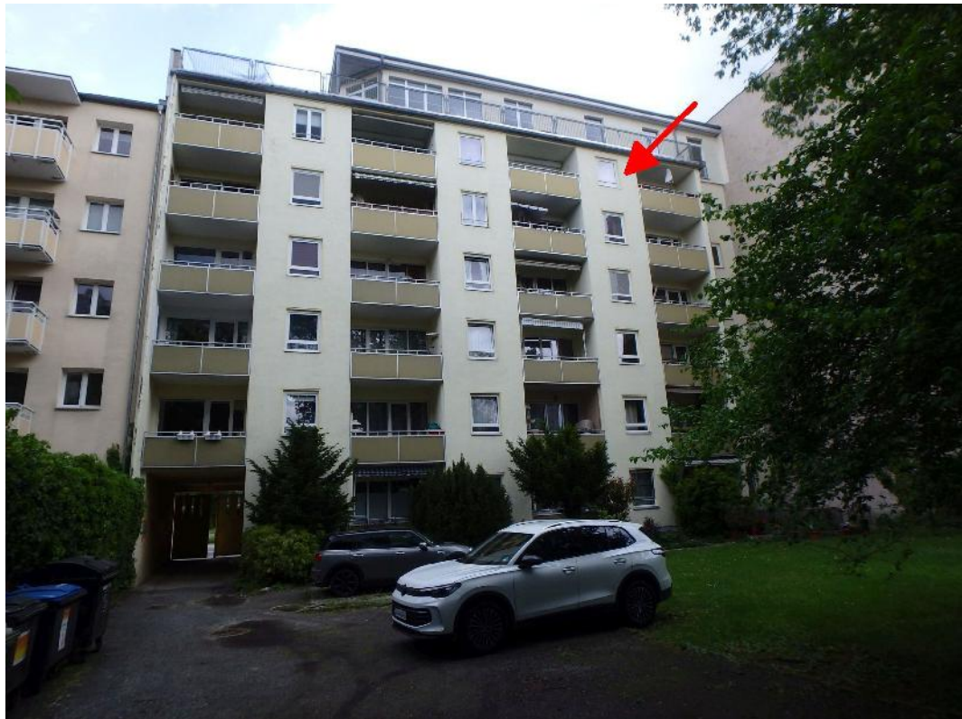
Mehrfamilienwohnhaus Südansicht (Hofansicht)
