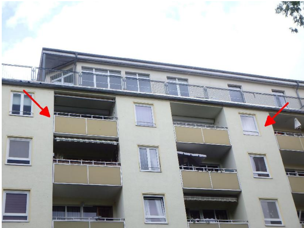
Mehrfamilienwohnhaus sowie Wohnungseigentum Nr. 11 + 22 Südansicht
