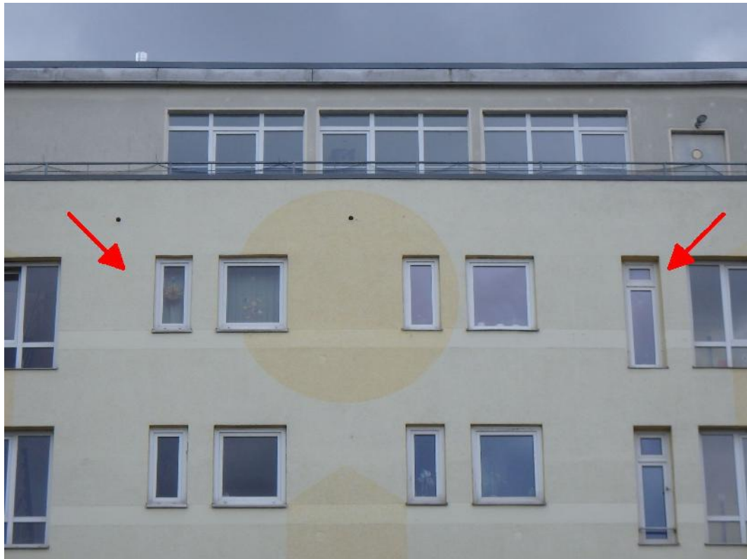
Mehrfamilienwohnhaus sowie Wohnungseigentum Nr. 11 + 22 Nordansicht
