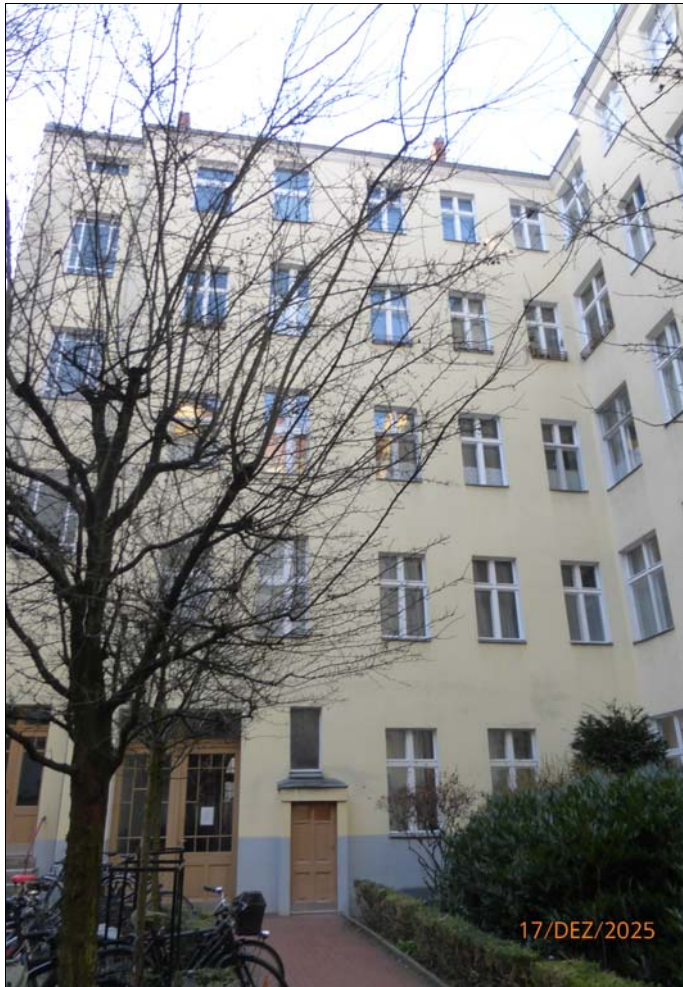
Quergebäude (vom Innenhof aus gesehen)
