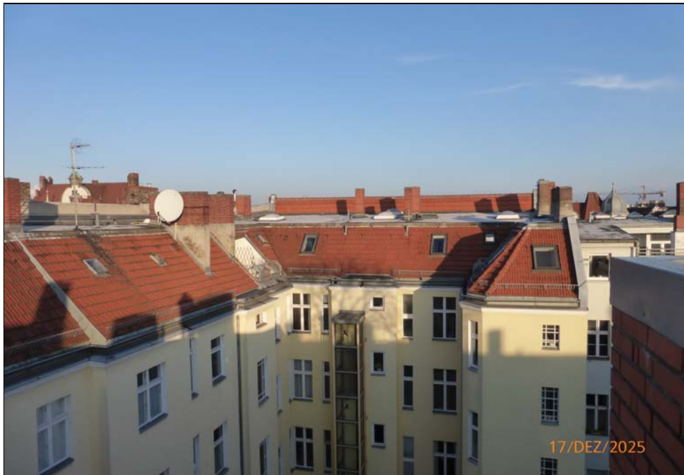
Dachflächen Seitenflügel und Vorderhaus
