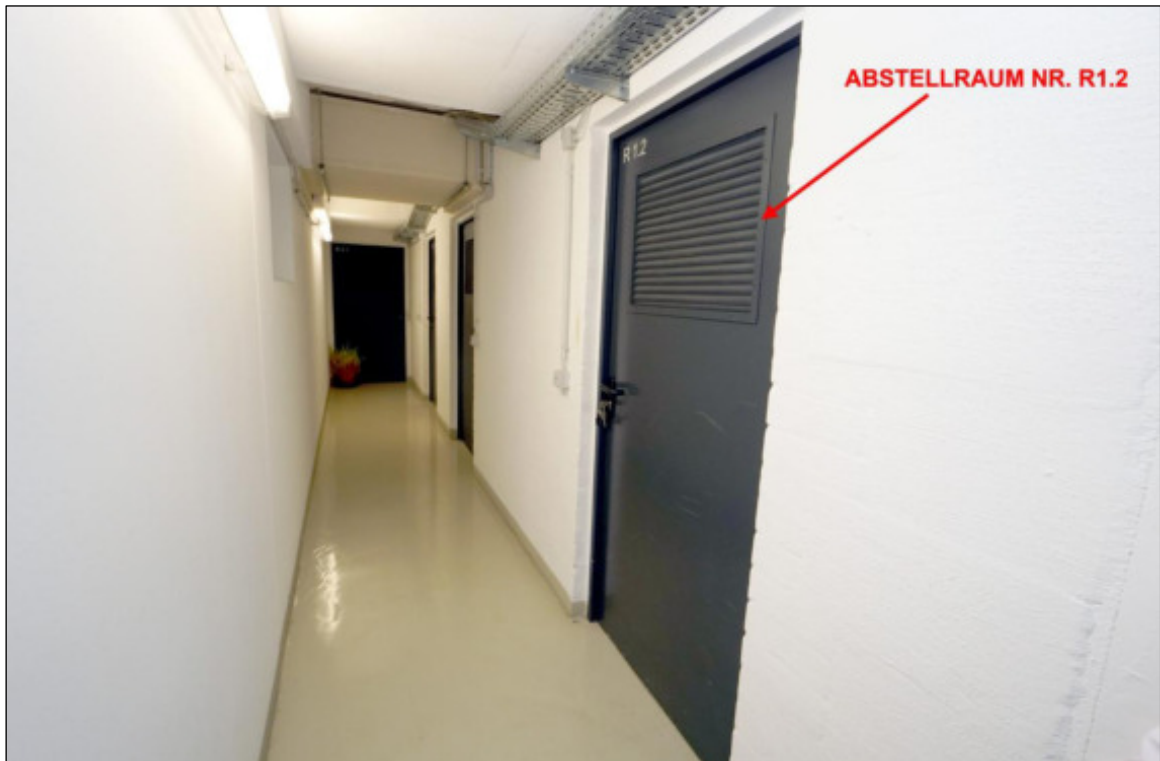
Keller, Abstellraum Nr. R1.2
