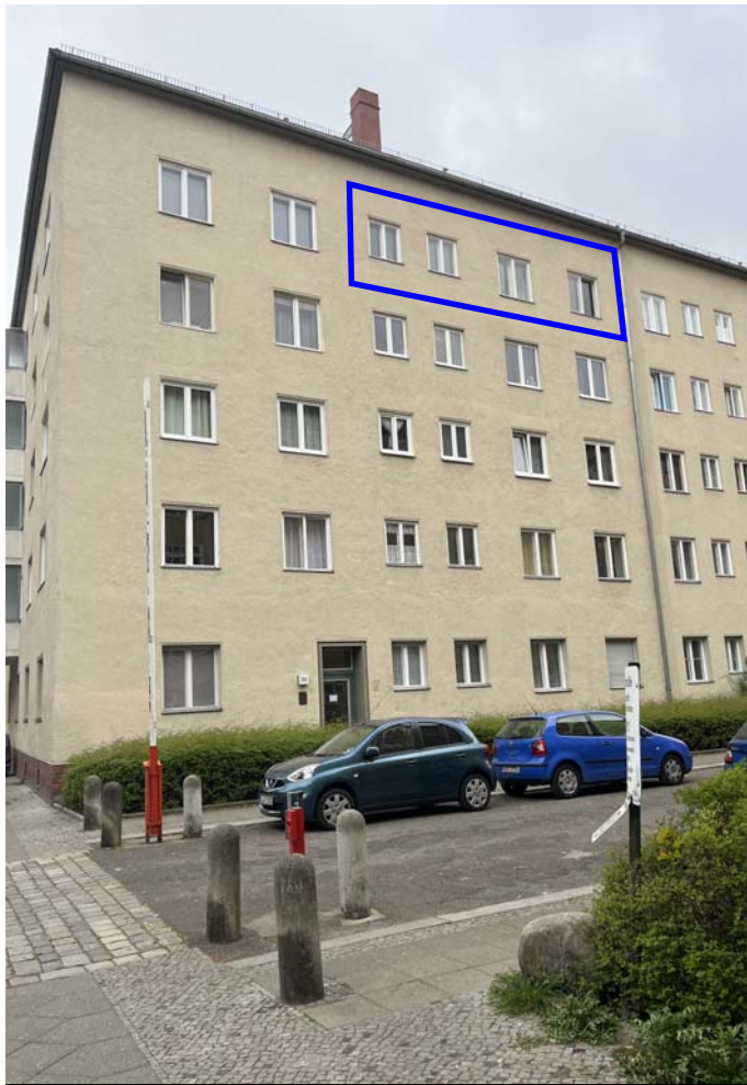
Straßenseitige Gebäudeansicht mit der betreffenden Wohnung Nr. 95
