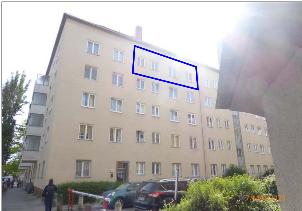
Straßenseitige Gebäudeansicht mit der betreffenden Wohnung Nr. 95
