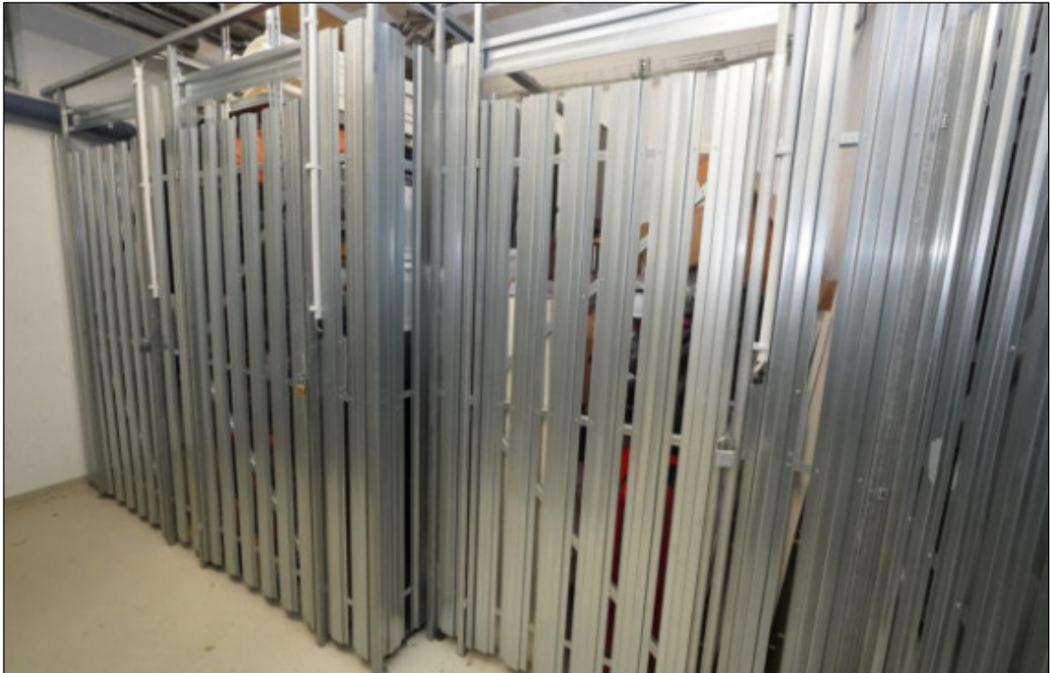
Kellerabstellräume im Gartenhaus
