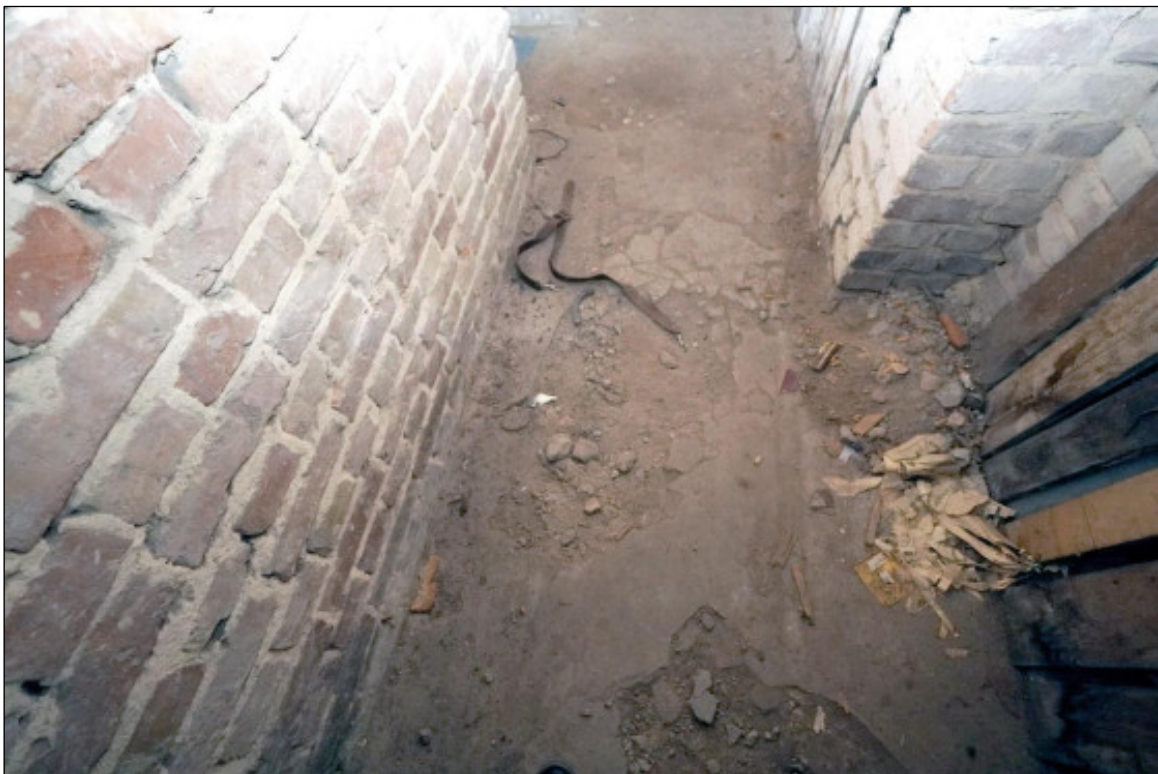
Kellerboden (Aufnahme vom 06.11.2024)
