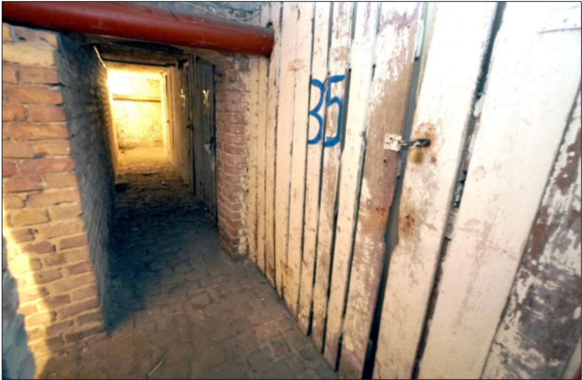
Kellerabstellräume (Aufnahme vom 06.11.2024)
