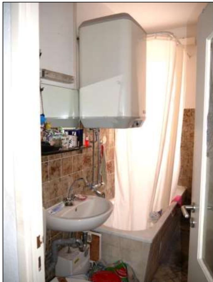
Badezimmer des Wohnungseigentums Nr. 8 im 1.OG postalisch rechts im Gebäudeteil Hildegardstr. 18A
