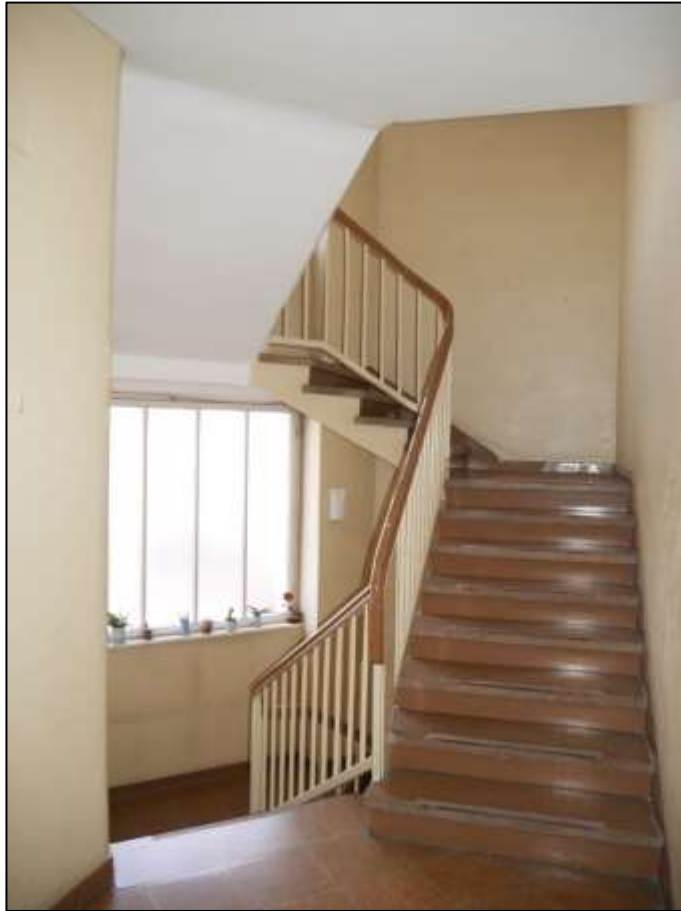
Treppenhaus- aufgang des Gebäudeteils Hildegardstr. 18
