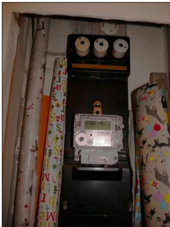
Sicherungstabelle im Flur des Wohnungseigentums Nr. 6 im 1.OG postalisch links im Gebäudeteil Hildegardstr. 18A
