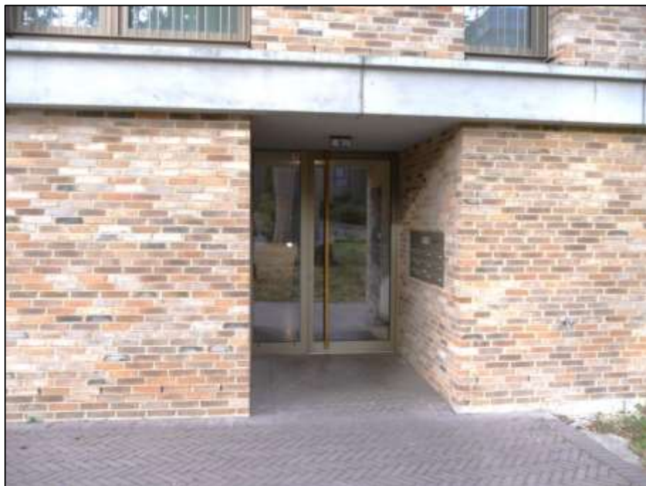
hinter die Fassade zurückgezogener Hauseingang zum Treppenhaus des Gebäudeteils Königsallee 16 J (Haus A)
