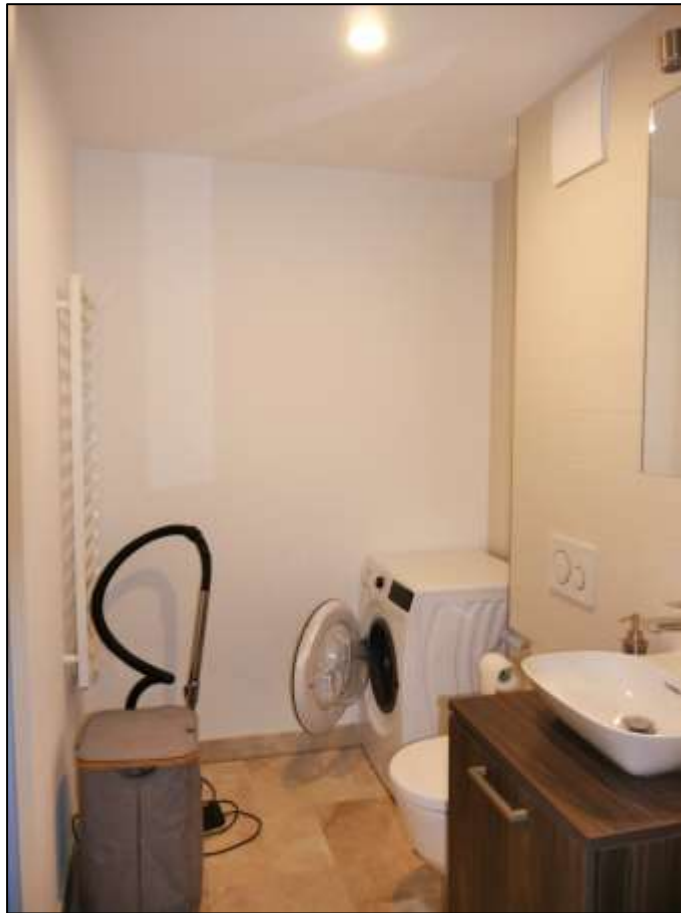
typischer innen- liegender Toi- lettenraum mit motorischer Be- lüftung und zu- sätzlichem Handtuchwär- mer
