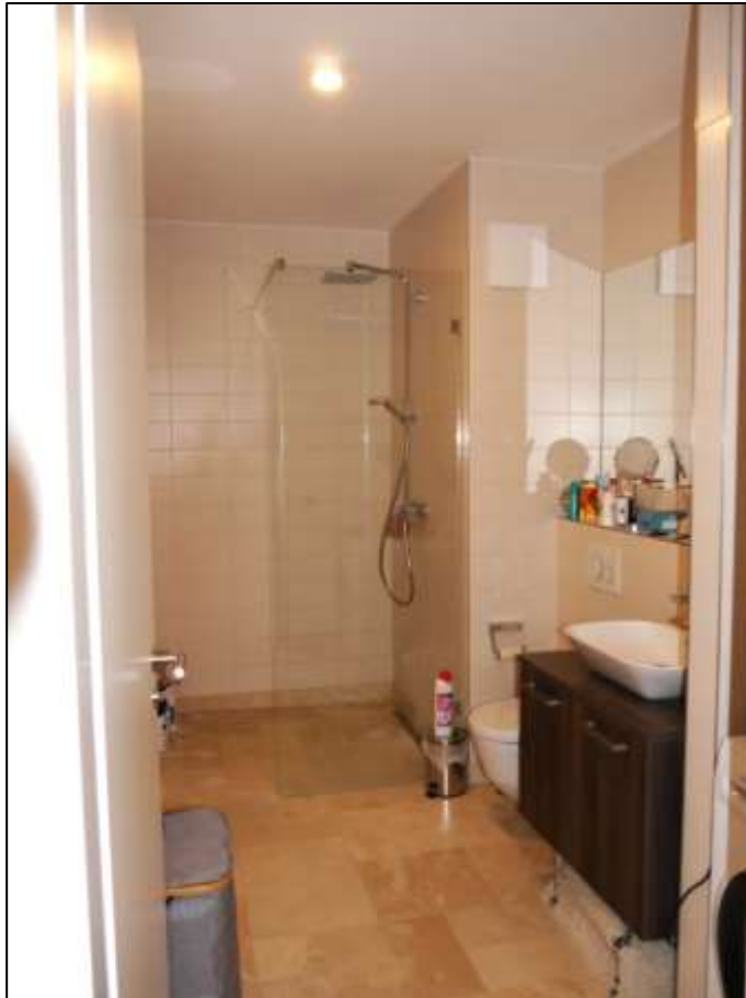
Duschbade- zimmer einer Wohnung mit bodengleichem Duschstand
