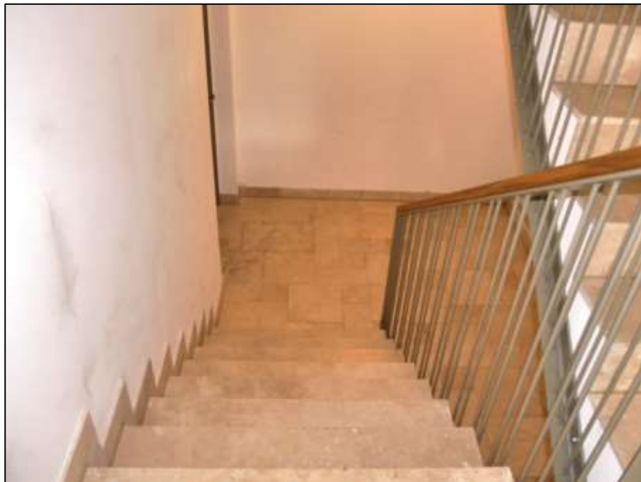
offener Kellertreppenabgang im Treppenhaus von Haus A
