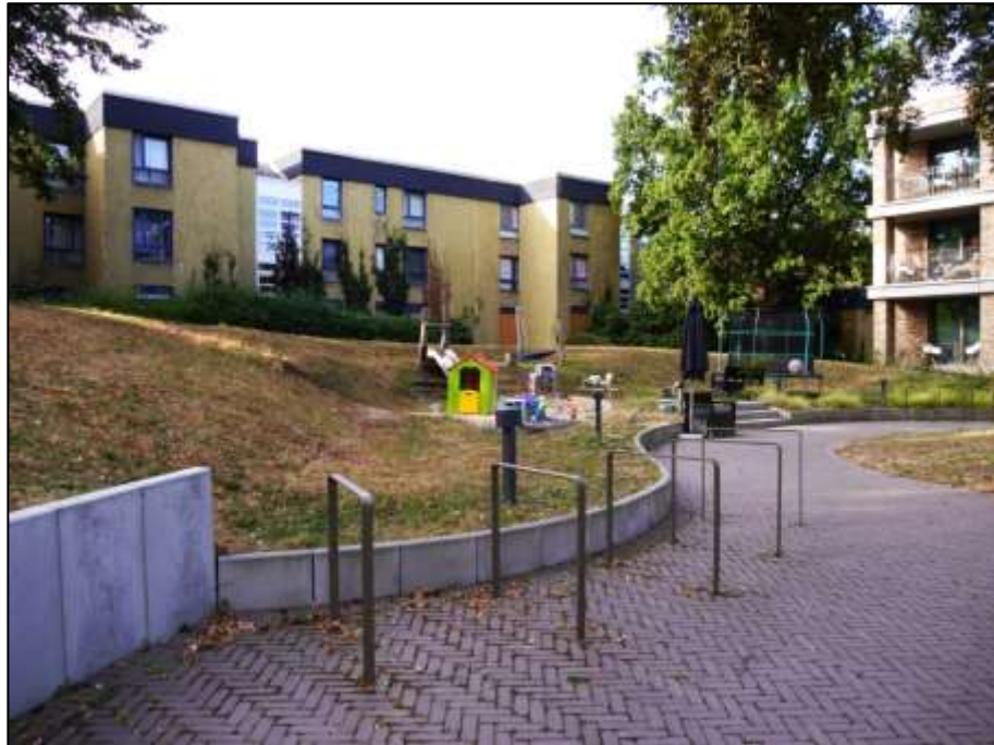
Blick auf die Hauszuwegung zum Vorplatz vor den rückwärtigen Hauseingangsfrenten der beiden auf dem Grundstück belegenen Gebäudeteile Koenigsallee 16 J als Haus A und Koenigsallee 16 I als Haus B mit Fahrradbügeln und Kinderspielplatz vor dem aufgehenden Gelände
