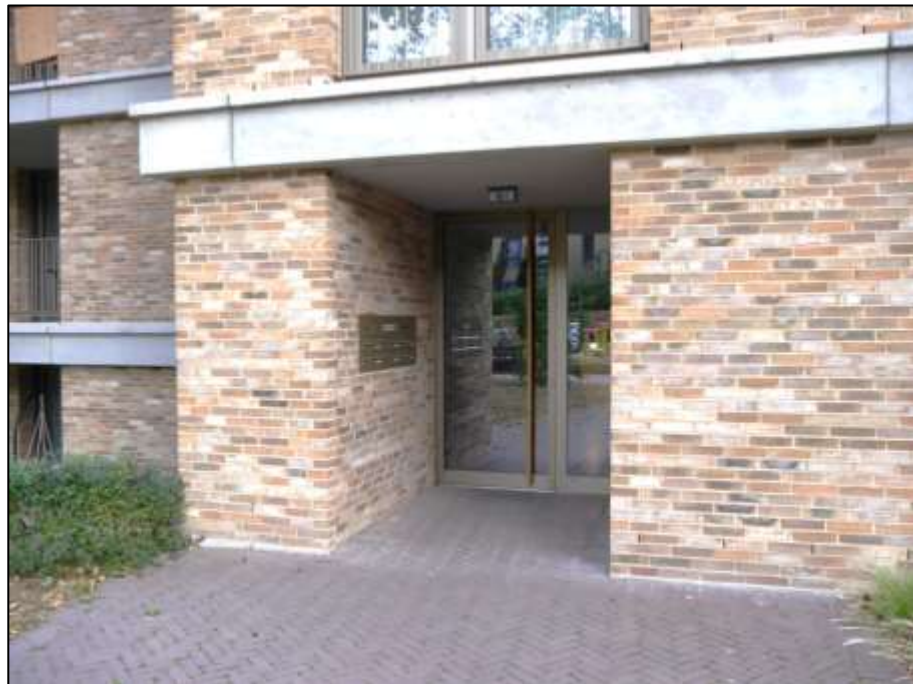
hinter die Fassade zurückgezogener Hauseingang zum Treppenhaus des Gebäudeteils Königsallee 16 I (Haus B)
