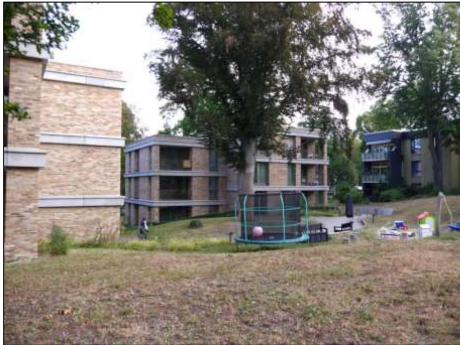
Blick aus dem Bereich der süd-westlichen Grundstücksgrenze auf die Hauseingangsfront von Haus B (Koenigsallee 16 I) im Hintergrund und die südliche Giebelseite von Haus A (Koenigsallee 16 J) im Vordergrund links
