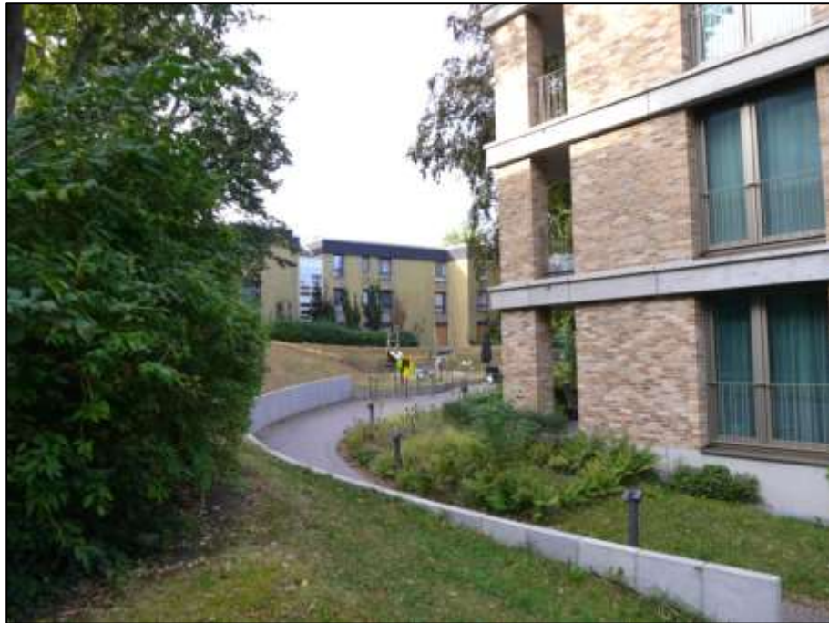
Blick auf die Hauszuwegung vor der östlichen Giebelseite des Gebäudeteils Königsallee 16 I
