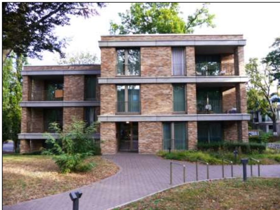
Hauseingangsfront von Haus B (Koenigsallee 16 I)
