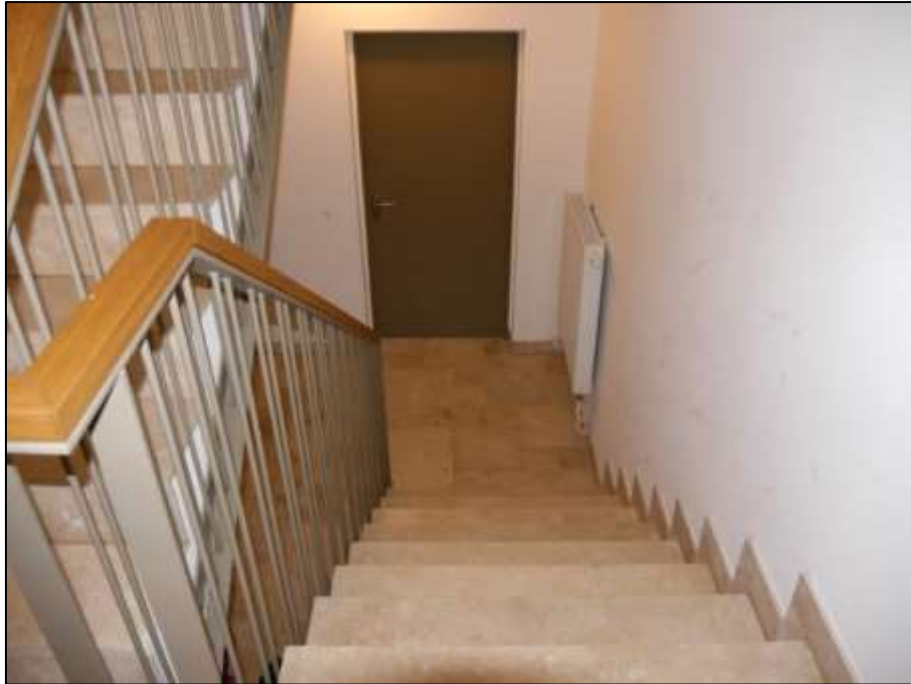
Austritt des offenen Kellertreppenabgangs im Treppenhaus des Gebäudeteils Koenigsallee 16 I (Haus B) mit anbindenden Kinderwagenabstellraum
