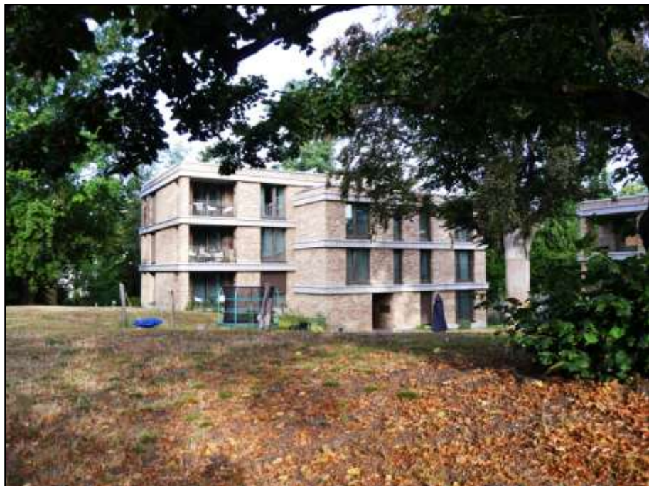
Blick aus der süd-östlichen Grundstücksecke auf die Hauseingangsfront von Haus A (Koenigsallee 16 J)
