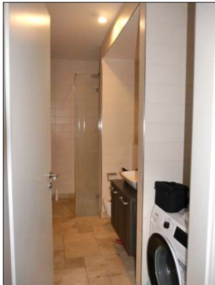
Duschbade- zimmer einer Wohnung mit bodengleichem Duschstand
