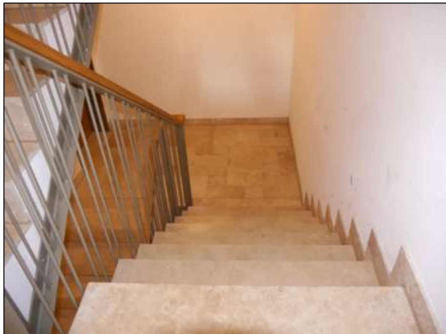
offener Kellertreppenabgang im Treppenhaus des Gebäudeteils Koenigsallee 16 I (Haus B)
