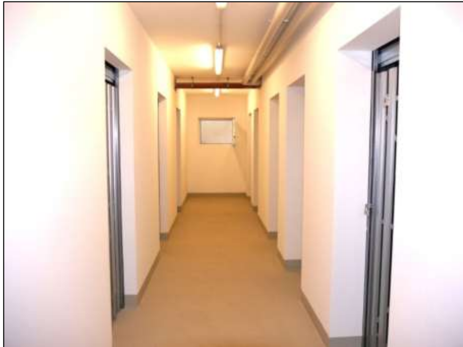
an die Kellerradie anbindender Zentralflur mit anbindenden Abstellkellerräumen der jeweiligen Wohnungen nebst Alu- oder Leichtmetall-Lamellentüren
