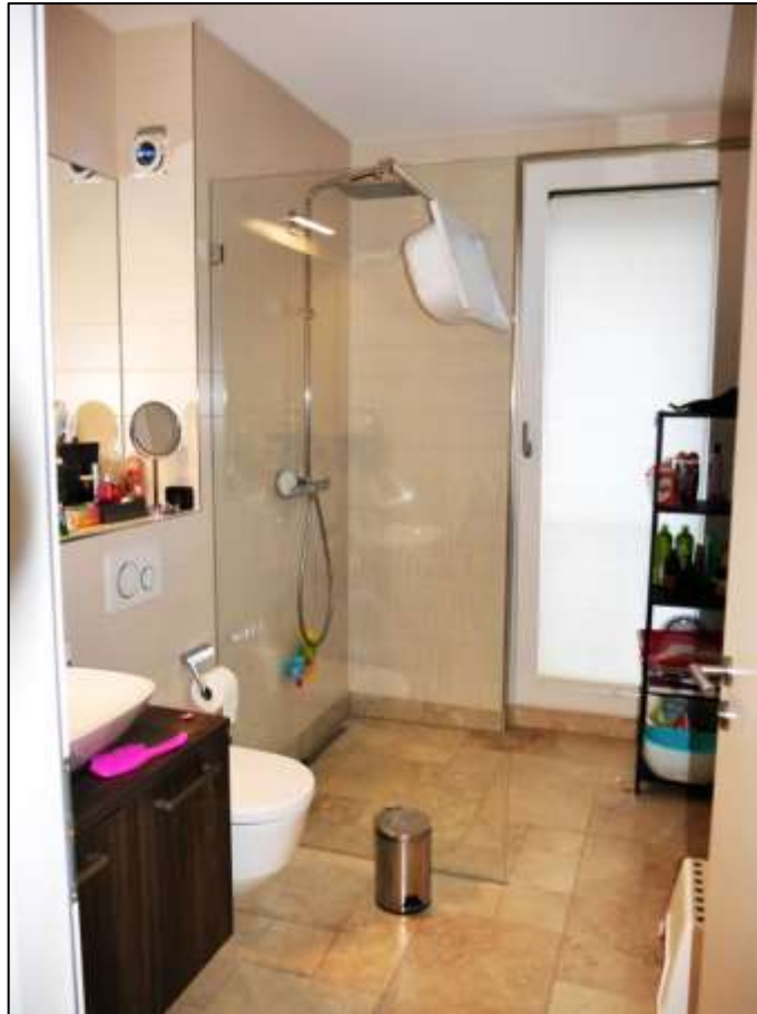
Duschbade- zimmer mit bo- dengleichem Duschstand
