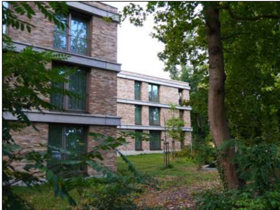
Straßenseitigen Gebäudefronten von Haus A (im Hintergrund) und Haus B (im Vordergrund)
