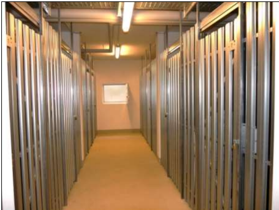
aus dem Treppenhaus links spannend abgehender Zentralflur im Kellergeschoss mit anbindenden Alu- bzw. Leichtmetall-Lamellenverschlüssen
