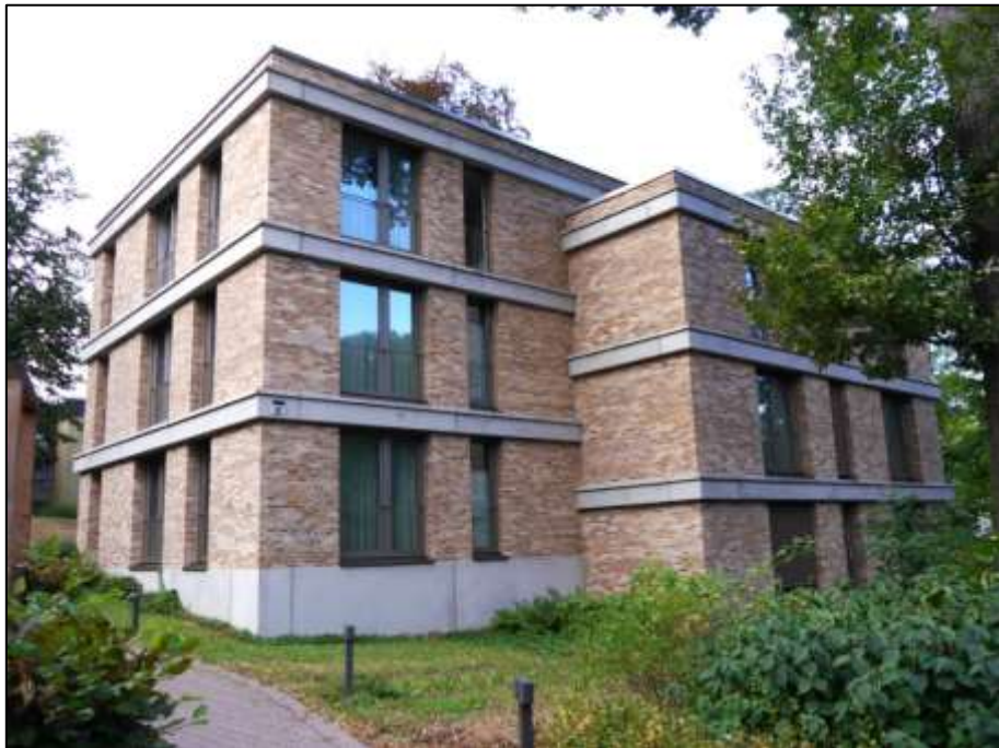
östliche Giebelseite (links) und straßenseitige Front von Haus B (Koenigsallee 16 I)
