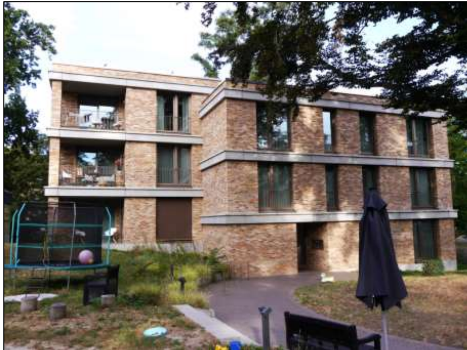
Hauseingangsfront von Haus A (Koenigsallee 16 J)
