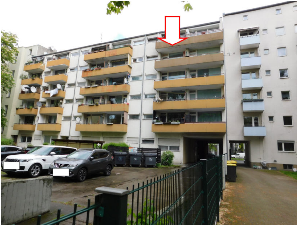
Kaiser-Friedrich-Straße 43, 44 in 10627 Berlin-Charlottenburg WE Nr. 15 im 4. Obergeschoss - Gebäudeansichten -
