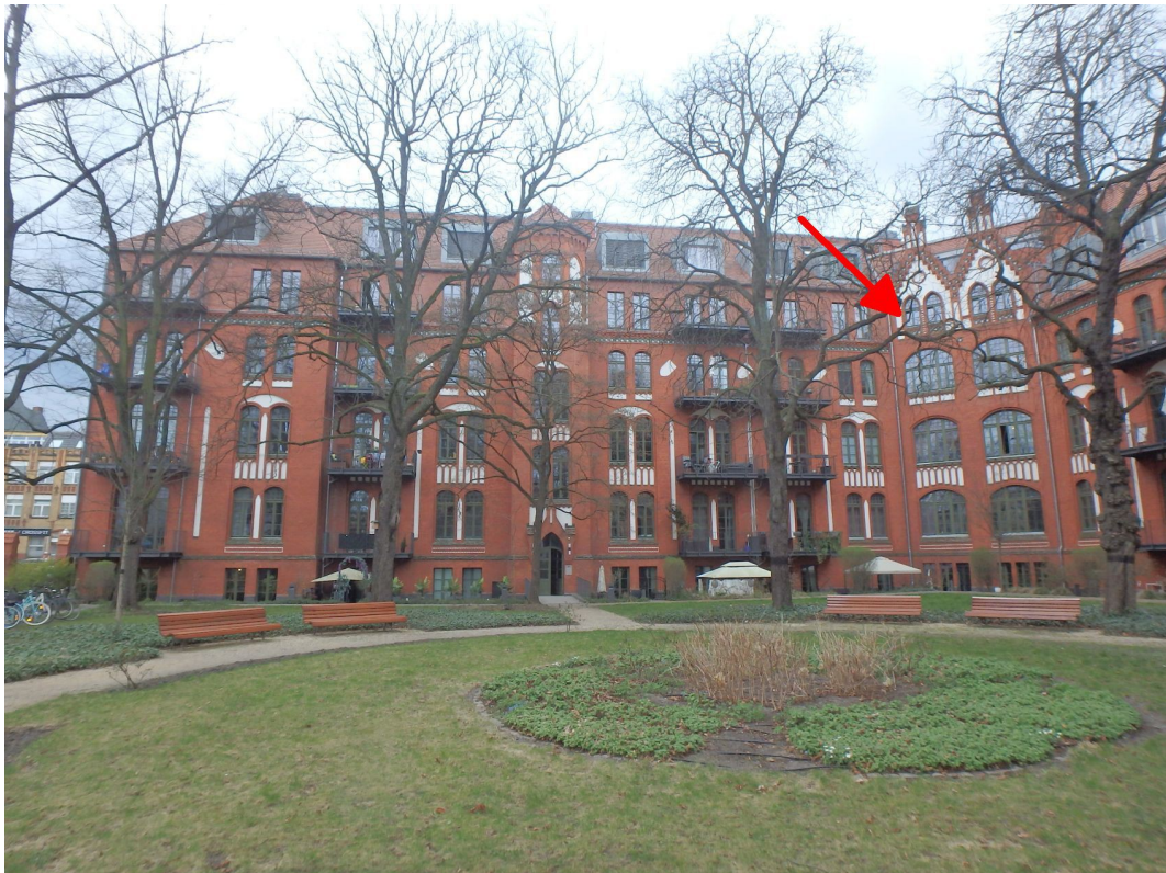
Wohnhausblock Ostansicht (Gartenansicht)
